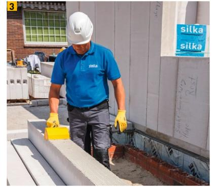
3 Vermörtelung der Stoffuge am liegenden Systemwandelement mit Dünnbettmörtel
