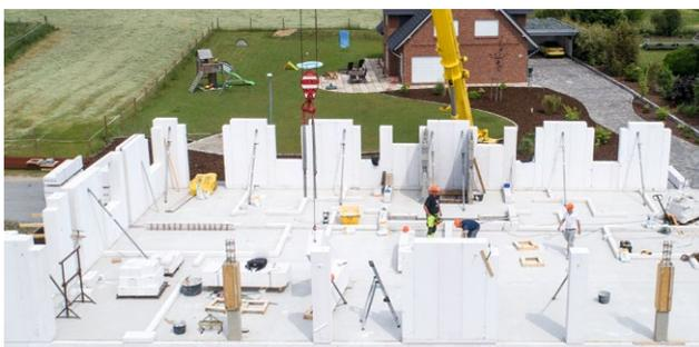
Die Längsseite des nächsten Elements wird mit Ytong fix P Dünnbettmörtel – mithilfe eines geeigneten Mörtelschlittens oder einer Ytong Plankelle – noch im liegenden Zustand aufgetragen.
