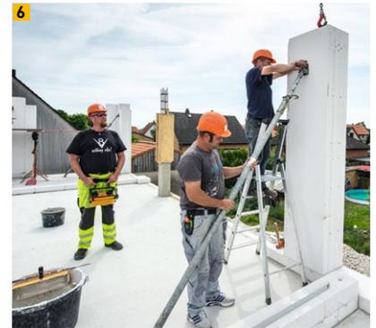
6 Jedes 4. Element mit Montagestütze sichern
