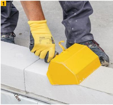
1 Ytong fix P Dünnbettmörtel vollflächig auf Ausgleichsschicht auftragen
