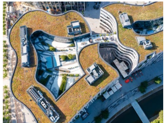
Kö-Bogen Düsseldorf, realisiert mit Multipor Dachdämmung DAA
