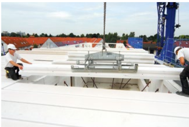
Verlegung von Ytong Dachelementen als Flachdach
