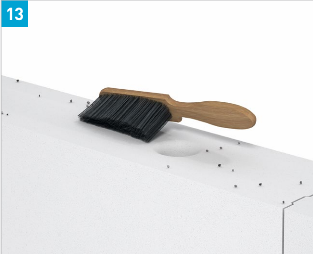
13 Steine vor dem Versetzen ober- und unterseitig abkehren
