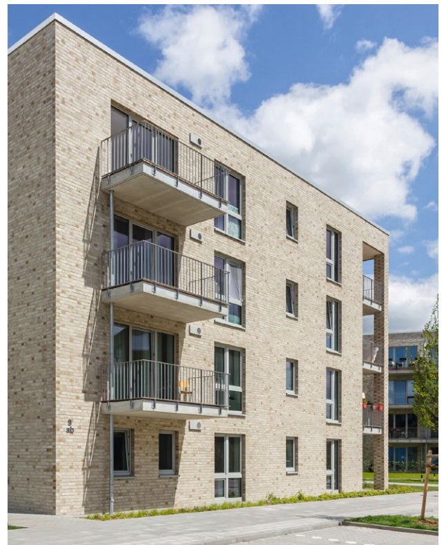
Großprojekt Mittlerer Landweg, Hamburg
