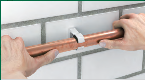
Rohr in die Halterung drücken
