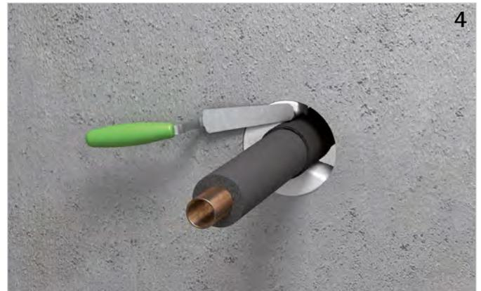
Ringspalt rauchgasdicht (mit z. B. Walraven Pacifyre® FPM Brandschutzmörtel) verschließen.
