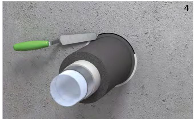
Rest- bzw. Ringspalt rauchgasdicht (mit z. B. Walraven Pacifyre® FPM Brandschutzmörtel) verschließen.
