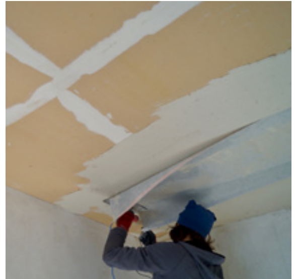
UdiSUN® beim Einspachteln
