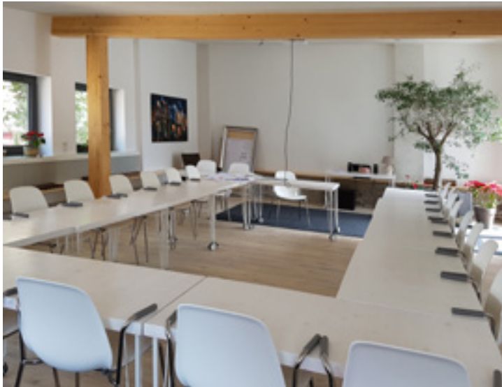
Tagungsraum mit Deckenheizung
