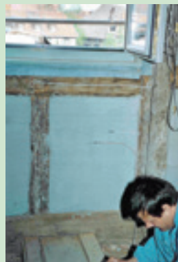
Verlegung der Messfühler
