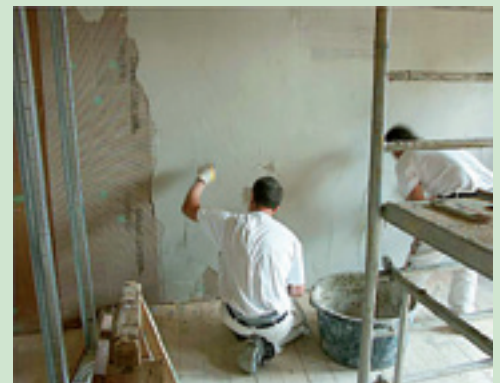
Spachtelung mit UdiMULTIGRUND® und Armierung
