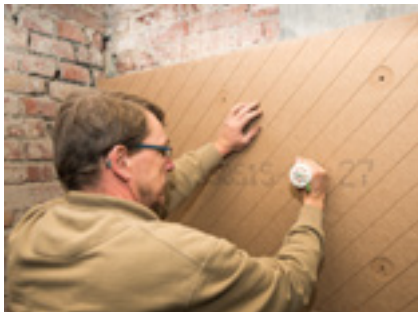
Dübel setzen
