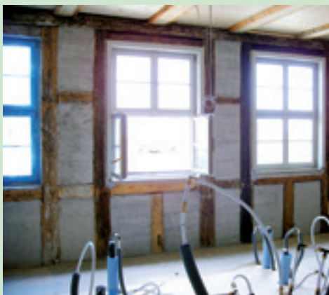
teilweise Erneuerung der Ausfachungen
