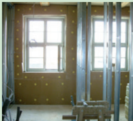
bereits montierte UdiIN® Holzfaserdämmplatten
