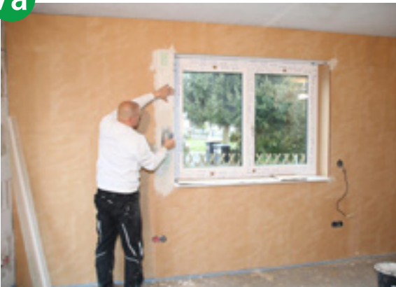
Setzen und Einspachteln der Eckschutzleisten
