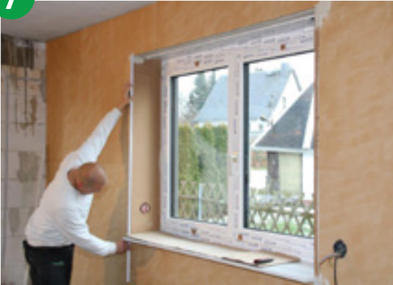
Ausmessen und Aufkleben der Laibungsplatten (20 oder 40 mm)
