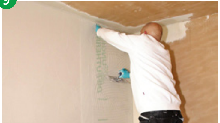
Abschließend wird der UdiGRUNDSPACHTEL® auf die verlegte Dämmfläche aufgezogen und das UdiARMIERUNG® Gewebe für Stabilität eingebettet.
