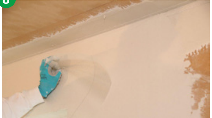
Setzen der Gewebeeckarmierung für dauerhafte Rissüberbrückung über den Ecken von Fenstern und Türen. Zweidimensionale Verstärkung der Oberfläche
