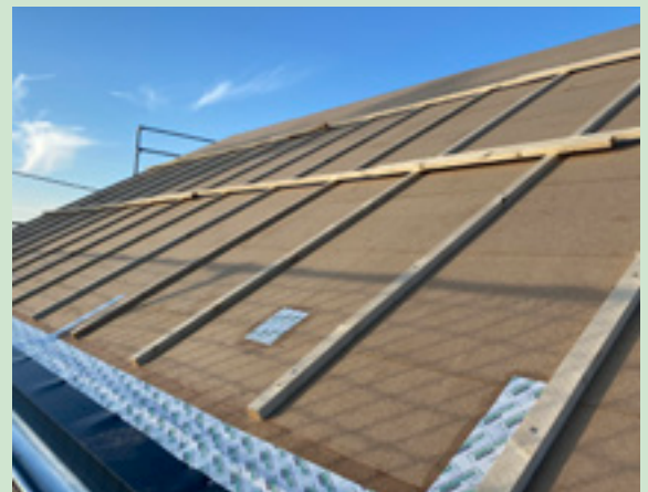
Unterdachplatte UdiTOP ® in 35 mm für hohen sommerlichen Hitzeschutz
