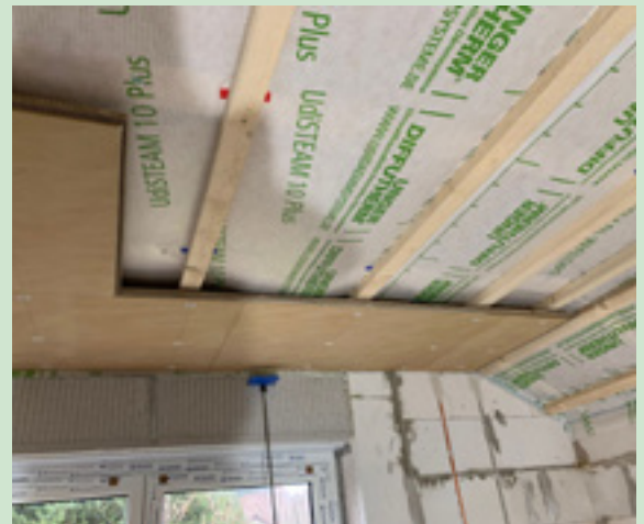
Dachausbau 1.OG Dampfbremse UdiSTEAM ® mit natürlicher Klimaausbauplatte UdiCLIMATE ® für optimalen Schallschutz
