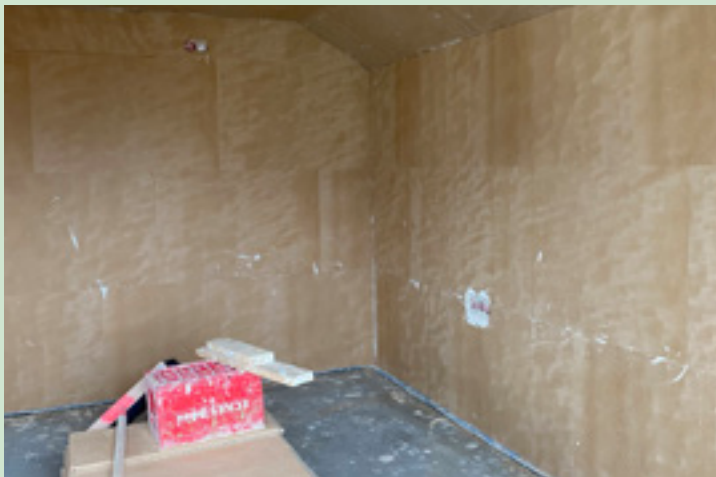
Innenwanddämmung mit UdiIN 2CM ®
