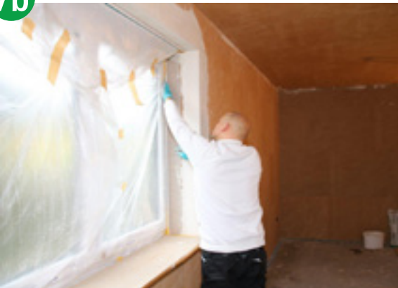
Selbstklebende Gewebeleiste mit Dichtband und Armierungsgewebe, sauberer Putzanschluss an Fenster- und Türrahmen bei Innendämmung
