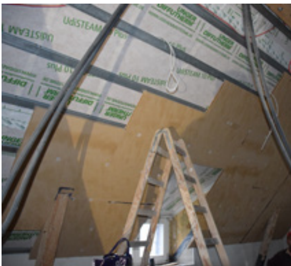
Dachausbau als Untersparrendämmung
