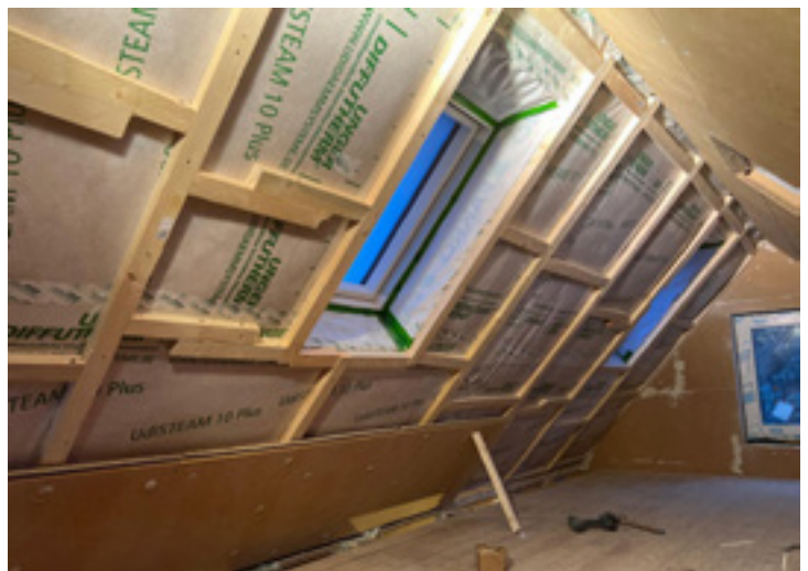
Direktmontage auf Holzständerkonstruktion
