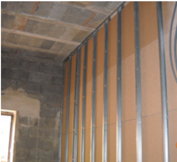
Zwischenwand Ständermontage
