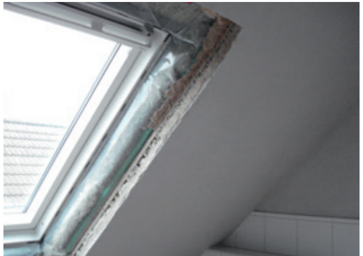
Nachträgliche Dämmung Dachschräge
