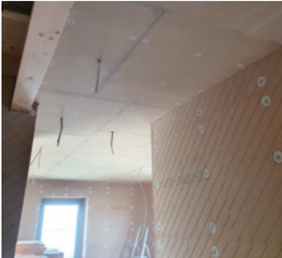
Deckenmontage Holzbalkendecke
