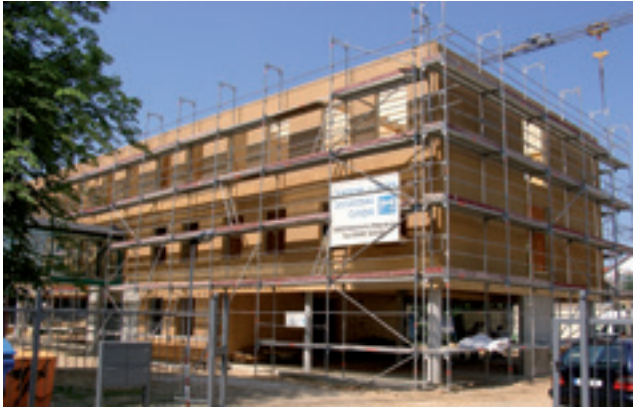
Objekt: Leipzig-Neukiritsch / Sachsen (Holzständerneubau mit UdiFRONT® 60 mm)
