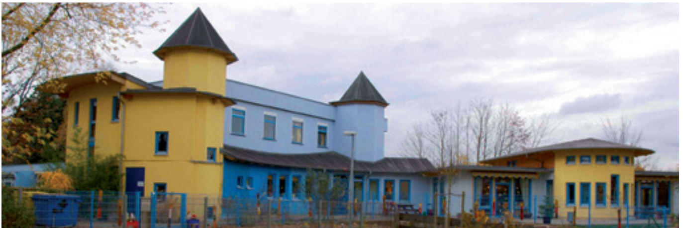
Objekt: Kindertagesstätte Oberursel im Taunus / Hessen (Holzständerneubau mit UdiFRONT® 80 mm)
