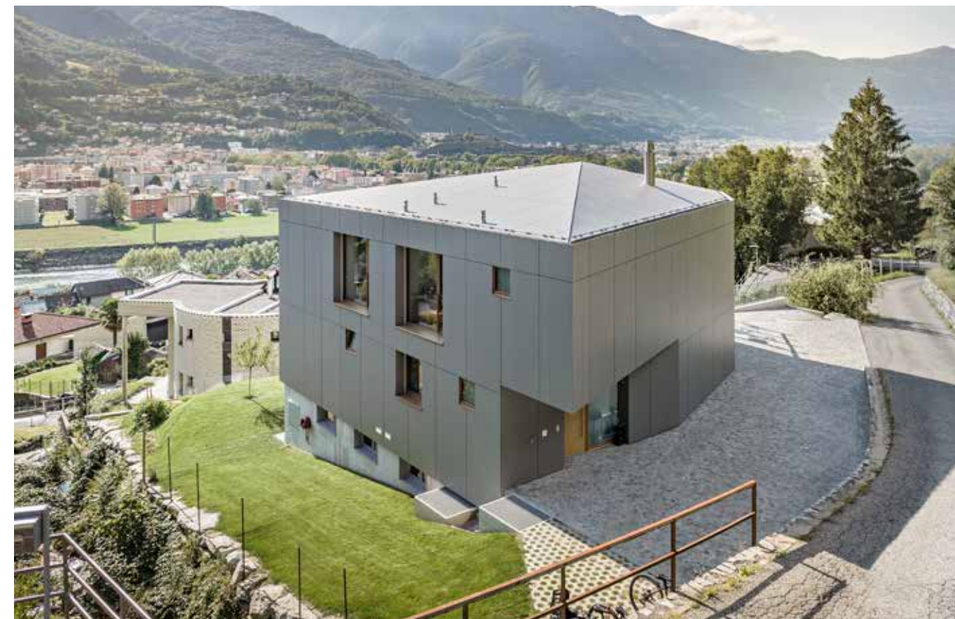
Malingamba, Bellinzona, Schweiz. Architekt: SAR 360 - Arch. Matteo Viganò, Castione, Schweiz. Fotograf: Meraner & Hauser OHG/SNC, Bozen, Italien.
