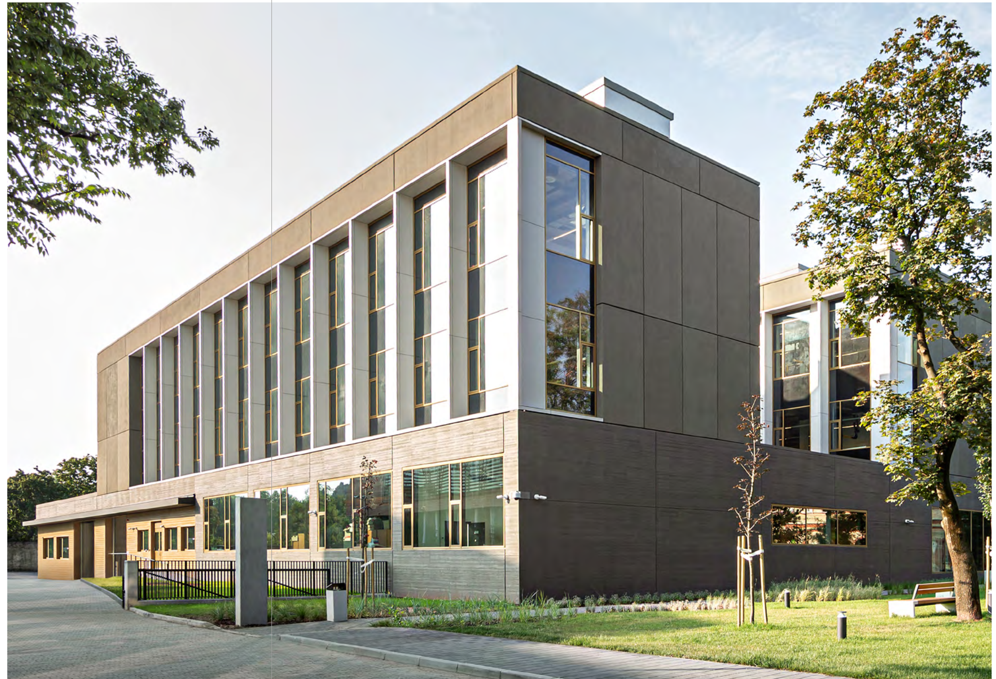
National Museum OMRRK, Budapest, Ungarn. Architekt: Narmer Építészeti Stúdió, Budapest, Ungarn. Fotograf: Meraner & Hauser OHG / SNC, Bozen, Italien.
