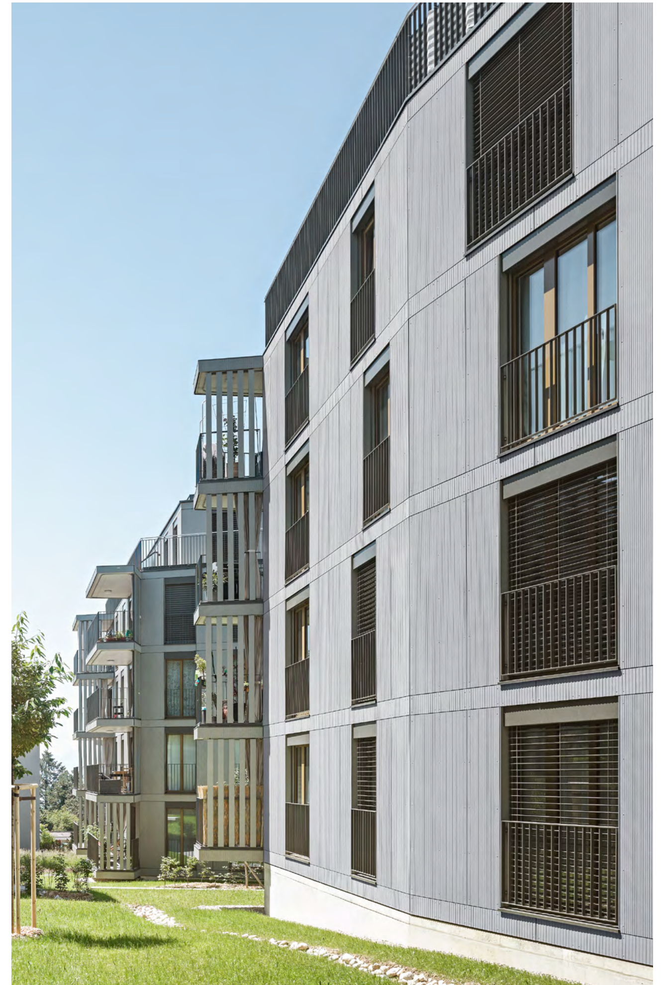
Fiches Nord, Lausanne, Schweiz. Architekt: Züst Gübeli Gambetti Architektur und Städtebau AG, Zürich, Schweiz. Fotograf: Roger Frei, Zürich, Schweiz.
