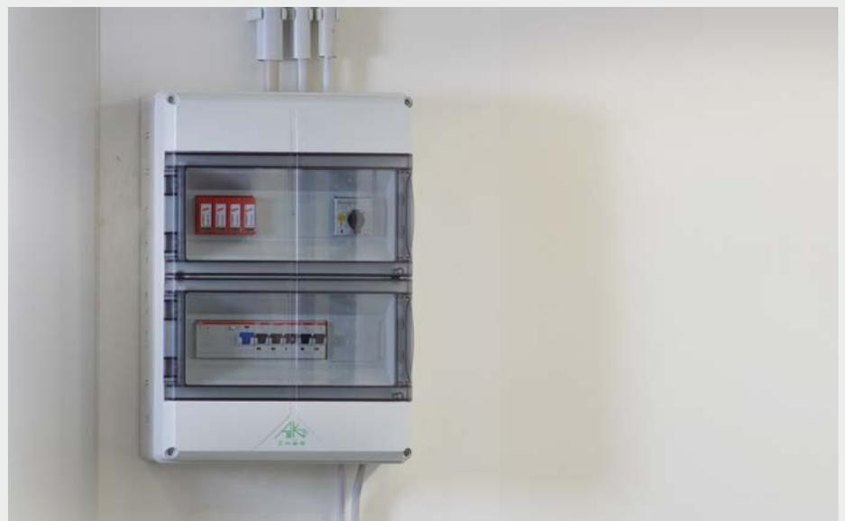
Die anschlussfertigen Steckdosenverteiler, können ohne großen Verdrahtungsaufwand an den Backup-Ausgang verschiedener Hybridwechselrichter angeschlossen werden. Durch die vorkonfektionierte Box, ist die Installation schnell erledigt und die Backup-Lasten können direkt an die Schuko-Ausgänge angeschlossen werden. Mit integriertem Fehlerstrom-Schutzschalter (RCD) für Personenschutz
