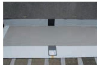
**11.** Nach Erhärtung des Verlaufsmörtels den überschüssigen Quarzsand entfernen (absaugen) und entsorgen.
