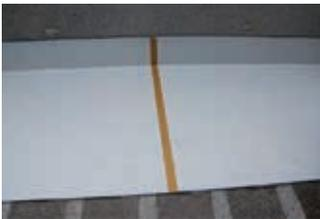
**5.** Das Verschließen der Matten-Stoßfuge erfolgt mittels Klebeband (Breite max. 20 mm) oder durch Überspachteln mit ALSAN 074.
