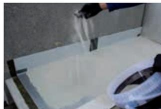
**10.** Die noch frische zweite Lage Verlaufsmörtel wird mit feuergetrocknetem Quarzsand der Körnung 0,4–0,8 mm im Überschuss abgestreut.
