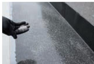
**14.** Optional kann in die noch frische Versiegelung in der Fläche eine Einstreuung mit ALSAN Chips zur optischen Aufwertung erfolgen. Anschließend ist sofort das Klebeband zu entfernen.
