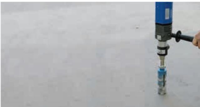
4. Ist der Untergrund in seinem gegebenen Schichtenaufbau **nicht bekannt** bzw. ist z. B. mit Hohlräumen und Feuchtigkeit tiefer im Untergrund zu rechnen, sollten **an definierten Stellen Kernbohrungen** durchgeführt und analysiert werden. Vor Ausführung muss die Lage der Bewehrung durch den Statiker geklärt sein.
