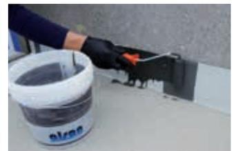
**12.** Aufkantung an aufgehenden Bauteilen mit Klebeband abkleben. Anschließend die Fläche mit ALSAN 970 F (RAL-Farbtönen nach Wahl) mit kleiner Rolle versiegeln. Bei glatten Flächen liegt der Verbrauch bei ca. 0,60 kg/m<sup>2</sup>.
