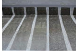
**3.** Den mineralischen, saugenden Untergrund mit ALSAN 170 grundieren. Durch die Applikation in Streifen (20 cm Breite im Abstand von ca. 5,0 cm grundieren) wird die Feuchtigkeit aus dem Untergrund über die Mattenstruktur abgeleitet. Auftrag erfolgt mit kleiner Rolle und Pinsel. Verbrauch: ca. 0,6–0,8 kg/m<sup>2</sup> (je nach Beschaffenheit des Untergrundes).
