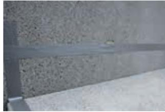
**2.** Fläche anschließend gründlich absaugen. Arbeitsbereiche abkleben. Hohlräume im mineralischen Untergrund sind zu vermeiden und mit Reparaturmörtel ALSAN 072 RS auszugleichen.
