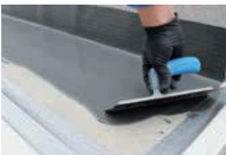
**13.** Zu bearbeitende Fläche mit Klebeband abgrenzen. Anschließend die Versiegelung ALSAN 970 F mit einer Glättkelle auf der abgesandeten Fläche applizieren. Bei abgestreuten Flächen liegt der Verbrauch bei ca. 0,80 kg/m<sup>2</sup>.
