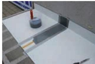
**6.** Mattenstöße (Breite ca. 17 cm) zuerst abkleben. Vorlegen der ersten Ebene mit dem Abdichtungsharz ALSAN 770. Verbrauch: ca. 1,5 kg/m<sup>2</sup>. Die Applikation erfolgt mit Rolle und Pinsel. Für die vertikalen Abdichtungsarbeiten wird ALSAN 770 TX eingesetzt.
