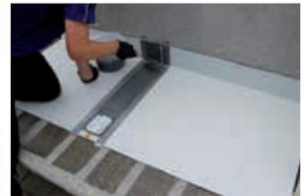
**8.** Aufbringen der zweiten Abdichtungsebene mit ALSAN 770. Verbrauch: ca. 1 kg/m<sup>2</sup>. Die Applikation erfolgt mit Rolle und Pinsel. Das ALSAN Fleece ist vollflächig einzubetten. Anschließend Klebeband sofort entfernen.
