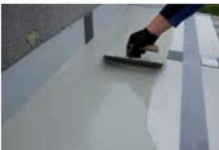
**9.** Der Verlaufsmörtel ALSAN 870 RS wird in zwei Lagen eingebaut. Die erste Lage (ca. 4,0 kg) wird mit einer Zahnkelle appliziert. Anschließend wird auf der ausgereagten ersten Lage mit einer Glättkelle die zweite Lage aufgetragen (ca. 2,0 kg).
