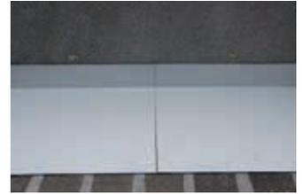
**4.** Die Vaporex Matte ist in die noch frische Grundierung einzulegen. **Achtung:** Die horizontale Vaporex Matte muss zum aufgehenden Bauteil einen Abstand von ca. 5,0 mm haben. Es muss dafür gesorgt werden, dass die Matte vollflächig auf dem Untergrund klebt. Falls nötig, muss ein weiterer Auftrag der Grundierung erfolgen und die Matte beschwert werden.
