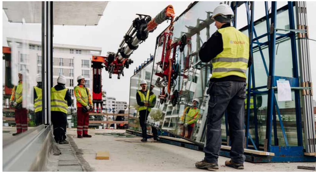
cero Montage im Lofthaus Molenpark, Frankfurt, durch das Solarlux-Team
