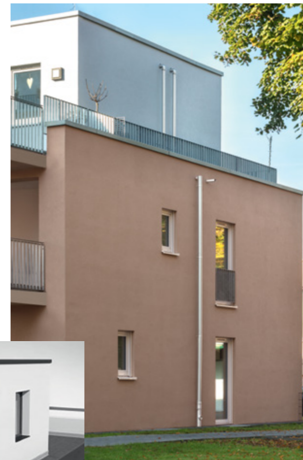
Kaskadenentwässerung - Wohnanlage Duisburg-Rumeln
