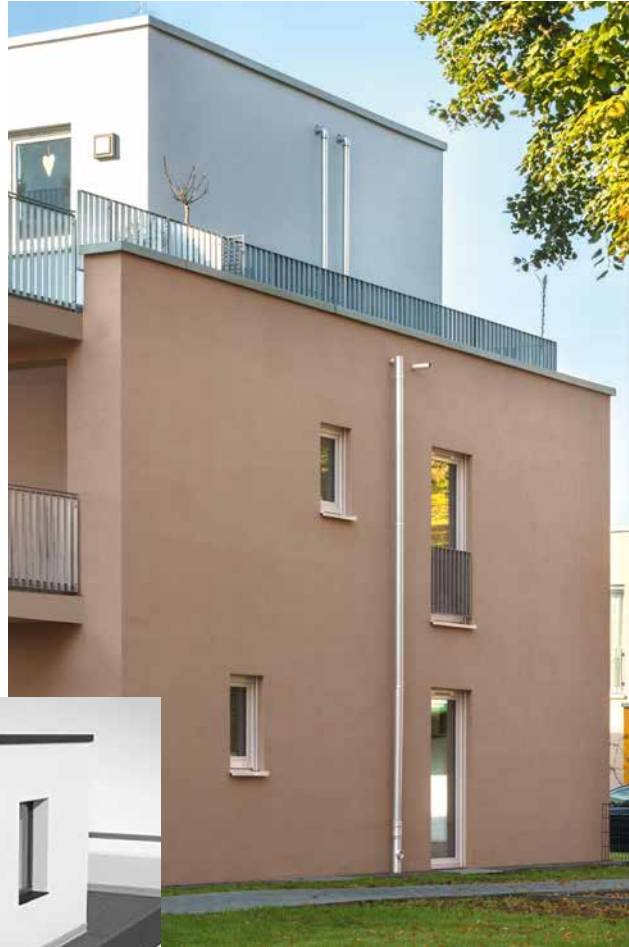
Kaskadenentwässerung - Wohnanlage Duisburg-Rumeln
