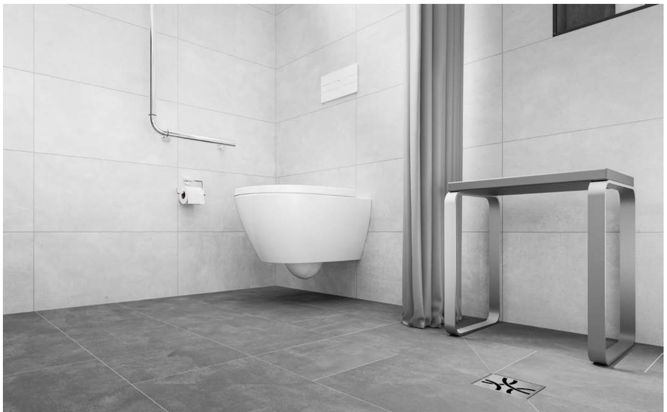
Der nahtlose Übergang der gefliesten Bodenfläche des Duschbereiches zu angrenzenden Bewegungsbereichen ermöglicht eine einheitliche Gestaltung der gesamten Bodenfläche.
