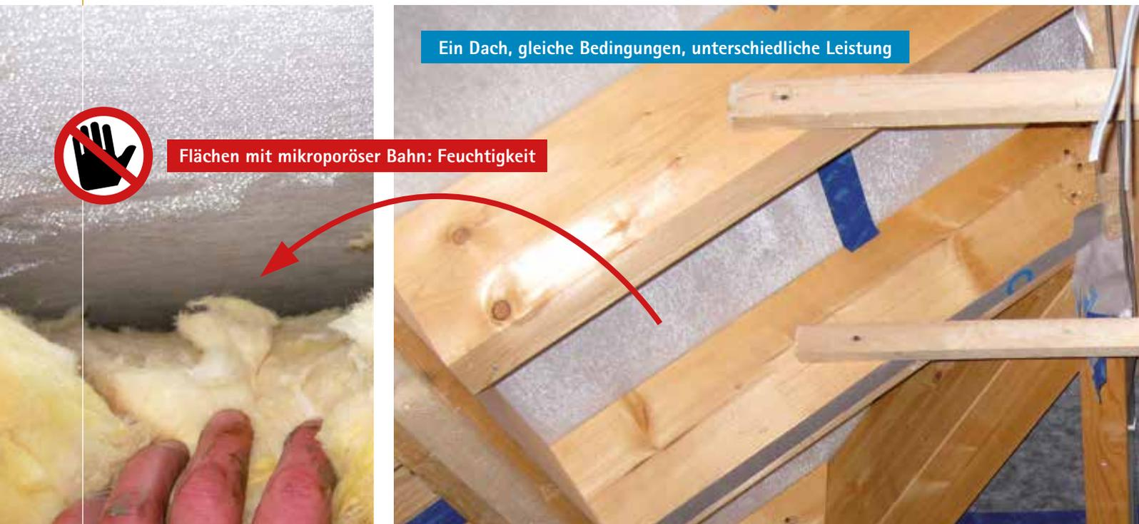
Flächen mit mikroporöser Bahn: Feuchtigkeit
