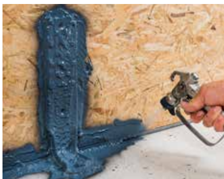
Luftdichtes Übersprühen von Befestigungswinkeln,
