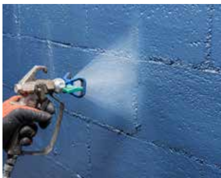
... unverputzten Wänden und
