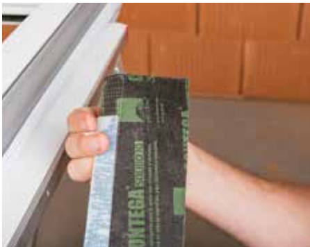
Trennfolienstreifen abziehen.
