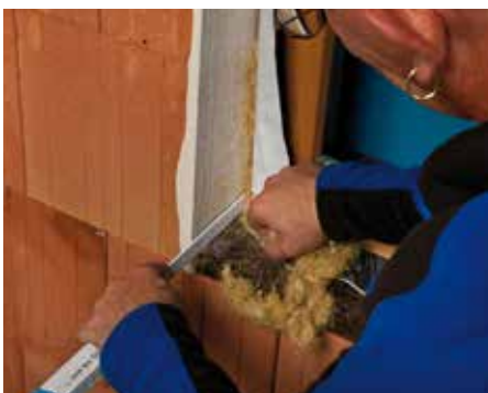
Fenster einsetzen und Fuge dämmen
