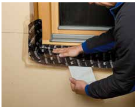
Einsatz als wasserdichte Unterfensterbank.
