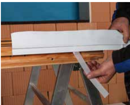
Oben am Blendrahmen verkleben
