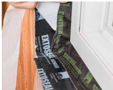
In Ecken luft- bzw. schlagregendicht verkleben.
