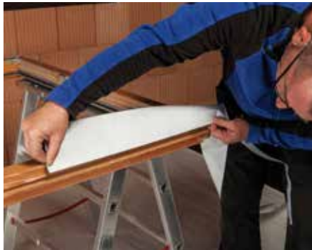
Oben am Blendrahmen verkleben
