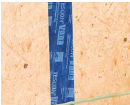
... und Bodenanschlüsse von Holzwerkstoffplatten,
