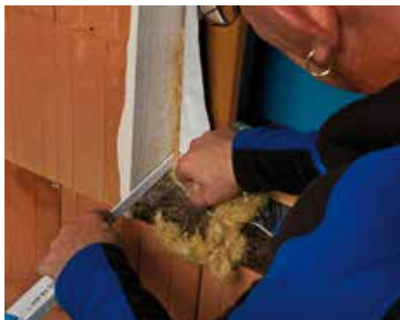
Fenster einsetzen und Fuge dämmen
