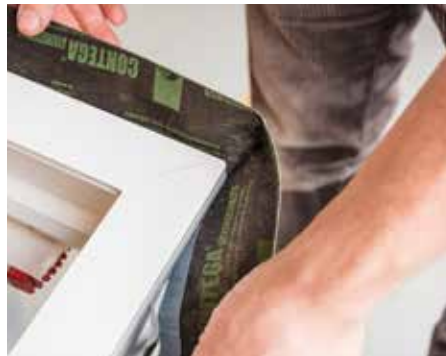
Eckschlaufe herstellen (Länge: 1,5 x Fugenbreite).
