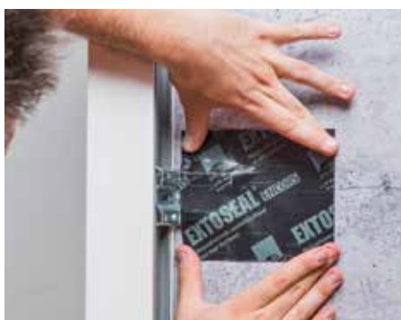
Wasserführende Verklebung von Befestigungswinkeln.
