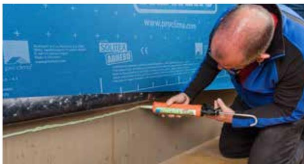
Anschluss an raue Untergründe, z. B. Betonbauteile Kleberauftrag d = mind. 5 mm auftragen.
