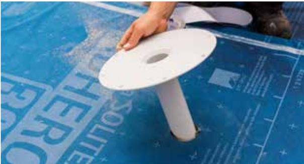
Für die Entwässerung der Fläche ein Ablaufelement einbauen und mit TESCON VANA faltenfrei verkleben. Eine kurzzeitige
