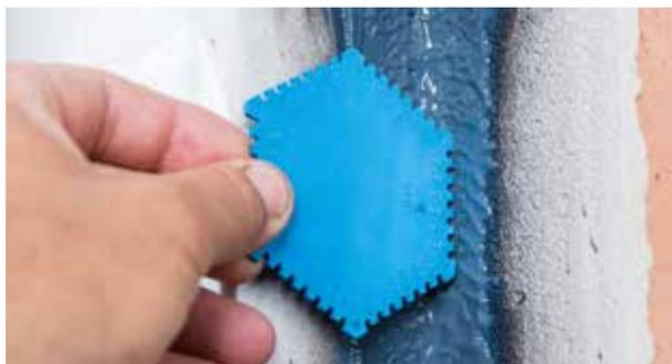
Während des Trocknens wechselt AEROSANA VISCONN die Farbe von blau zu schwarz. AEROSANA VISCONN white hat keinen Farbumschlag. Der Feuchte Film ist vor Feuchtigkeit (z. B. Regen) bis zur vollständigen Durchtrocknung zu schützen. Unmittelbar nachdem die Sprüharbeiten beendet sind Airless-
