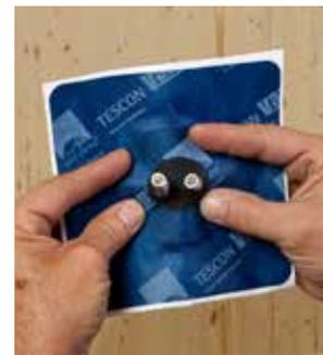
Kabel können mit den vorgefertigten Manschetten KAFLEX mono, KAFLEX duo oder KAFLEX post geschlossen werden.
