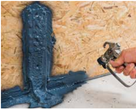
Luftdichtes Übersprühen von Befestigungswinkeln,
