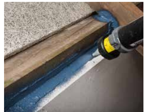
... in schwierigen Sanierungssituationen.
