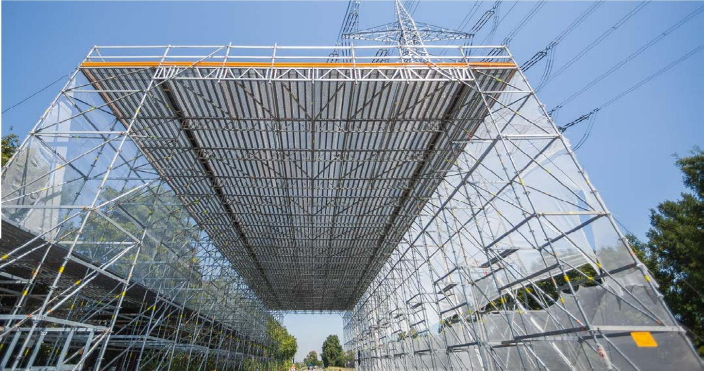
► Mithilfe des Gitterträgers ULS Flex, bestehend aus fünf Einzelbauteilen mit maximal 1,50 m Länge und höchstens 15,4 kg Einzelgewicht, können Sie Überbrückungen bis zu 8,50 m Spannweite herstellen.
