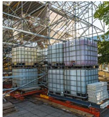
Gut kombiniert: VARIOKIT Systembauteile dienen zur Lastverteilung versetzt angeordneter Gerüststiele und als integrierter Auflagerrost für die Wassertankballastierung.
