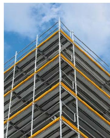
Für die Ausbildung von Außenecken wird kein zusätzlicher Rahmensegler benötigt – und die Beläge einfach an dem Horizontalriegel des angrenzenden Gerüstfelds montiert.
