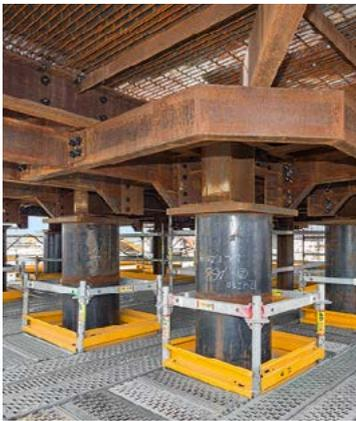
Aufgrund des selbstsichernden Riegelanschlusses an dem Gerüstknotten (Gravity Lock) und der integrierten Abhebesicherung der Beläge beschleunigt sich Ihre Montagegeschwindigkeit.
