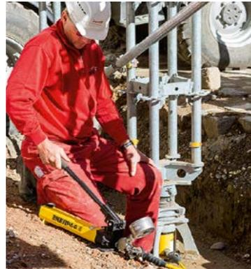
Die Hydraulik-Einheit besteht aus Hubzylinder und Handpumpe. Am Manometer können Sie sowohl den Druck [bar] als auch die Kraft [kN] ablesen.
