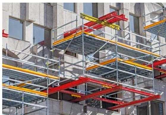
Der PERI UP Gerüstbaukasten ermöglicht Ihnen in Kombination mit VARIOKIT sichere Zugänge zu unterschiedlichsten Arbeitsbereichen. Auch Arbeitsflächen sind einfach integrierbar.
