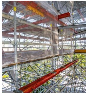
Die PERI Gerüstlösung zur Einrüstung der komplexen Fachwerkkonstruktion basiert auf PERI UP und VARIOKIT – zwei miteinander kombinierbaren Systemen.
