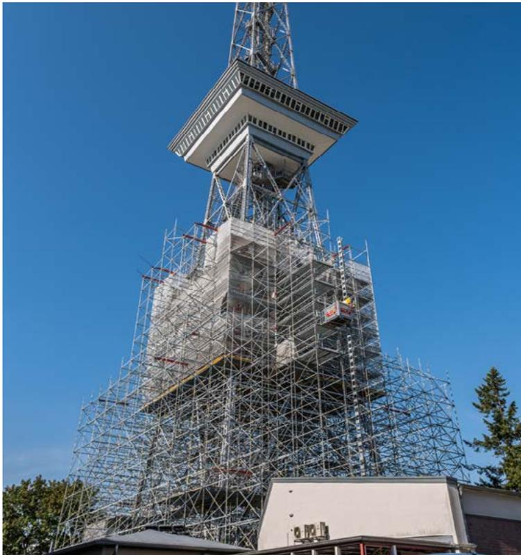
Der alte Anstrich musste entfernt, der Korrosionsschutz erneuert und die Stahlkonstruktion komplett neu beschichtet werden.
