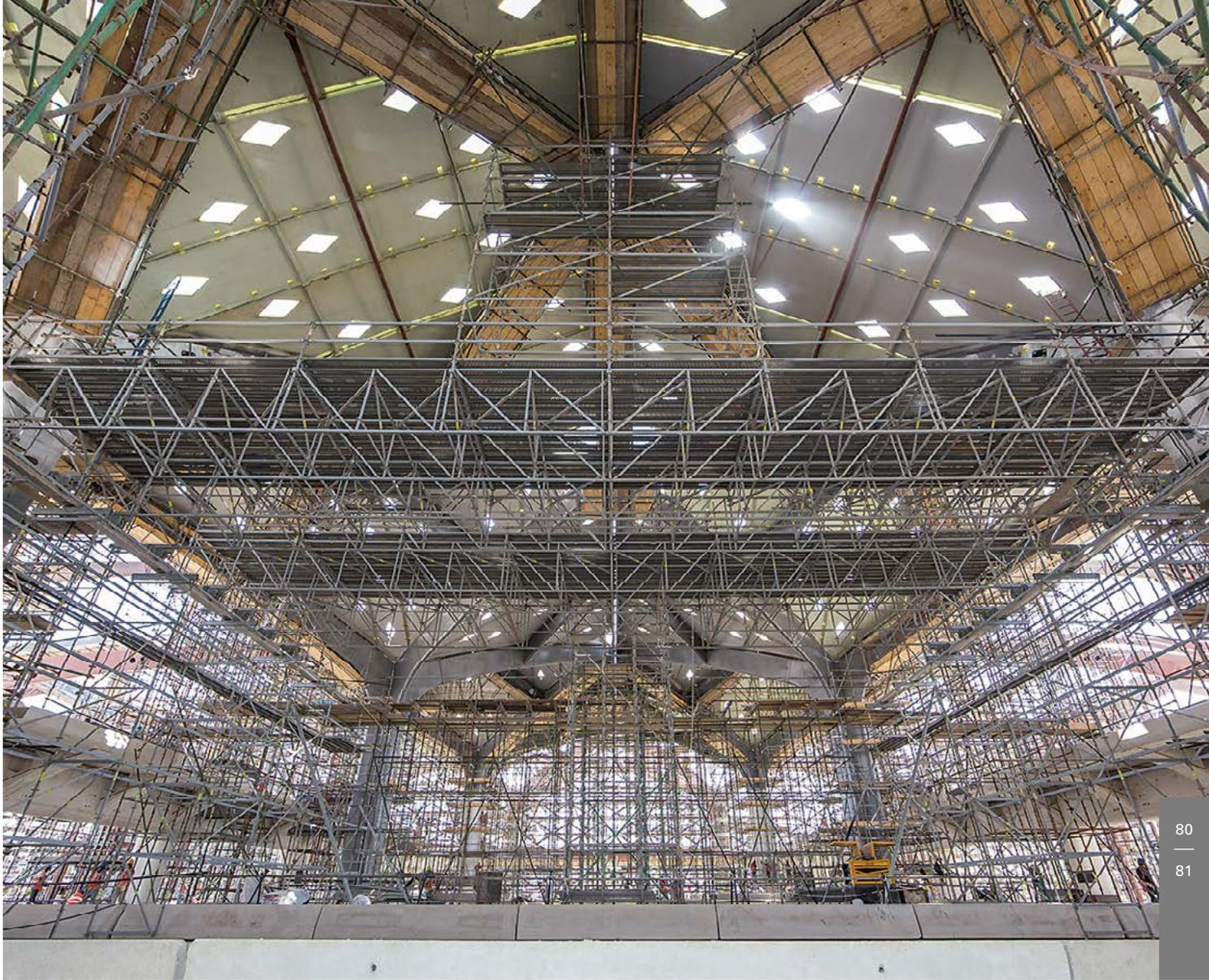
Verfahrbare Plattformen bieten sichere Arbeitsflächen für verschiedene Tätigkeiten an der Untersicht einer Bahnhofsoberdachung.
