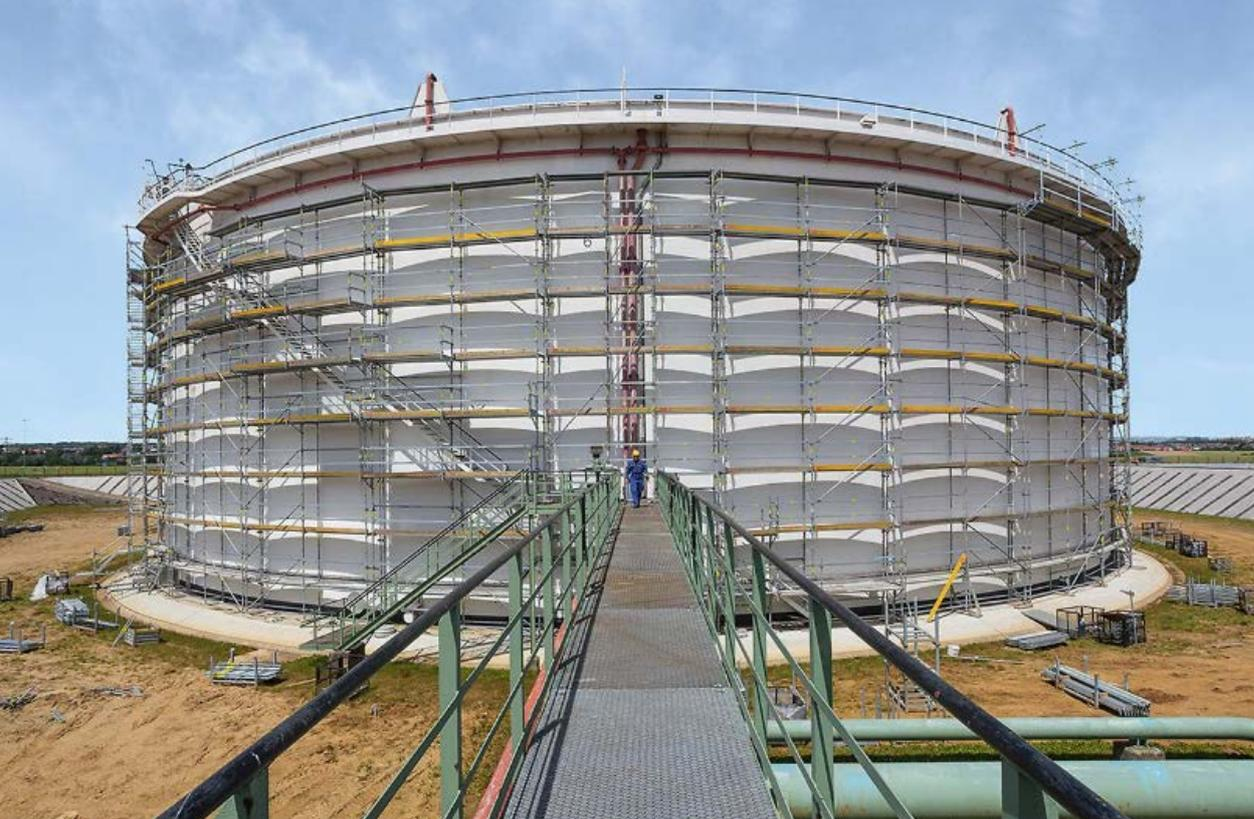
Die Breite des Gerüsts ist nahezu beliebig wählbar und kann an vielfältige Anforderungen angepasst werden. Auch runde Bauwerke sind mit dem PERI UP Fassadengerüst aus Kernbauteilen einfach einrüstbar.
