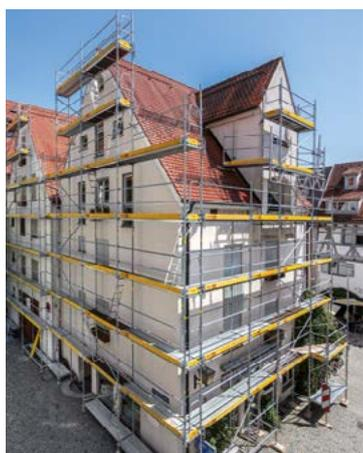
Das Fassadengerüst aus dem PERI UP Gerüstbaukasten zeichnet sich neben vielen durchdachten Bauteildetails auch durch das geringe Gewicht der Einzelbauteile aus. So erleichtert beispielsweise der Easystiel mit seinen nur 7,2 kg den Gerüsttransport und -aufbau.
