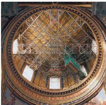
Mit dem LGS Fachwerkbindersystem können Sie sichere Arbeitsplattformen erstellen. Bei Bedarf entstehen mit Systembelägen und staubdichten Abdeckungen geschlossene Flächen.
