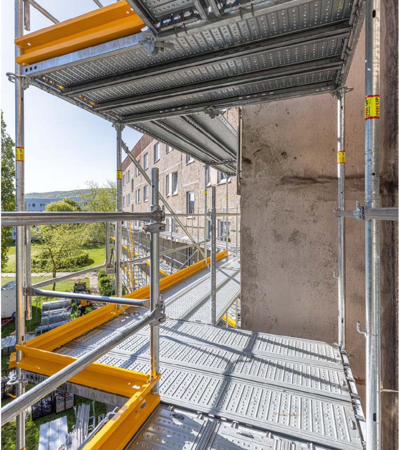
Die ebenen Belagsflächen und der umlaufende Seitenschutz sorgen für eine sichere Arbeitsumgebung und erleichtern die Ausführung der unterschiedlichen Fassadenarbeiten.
