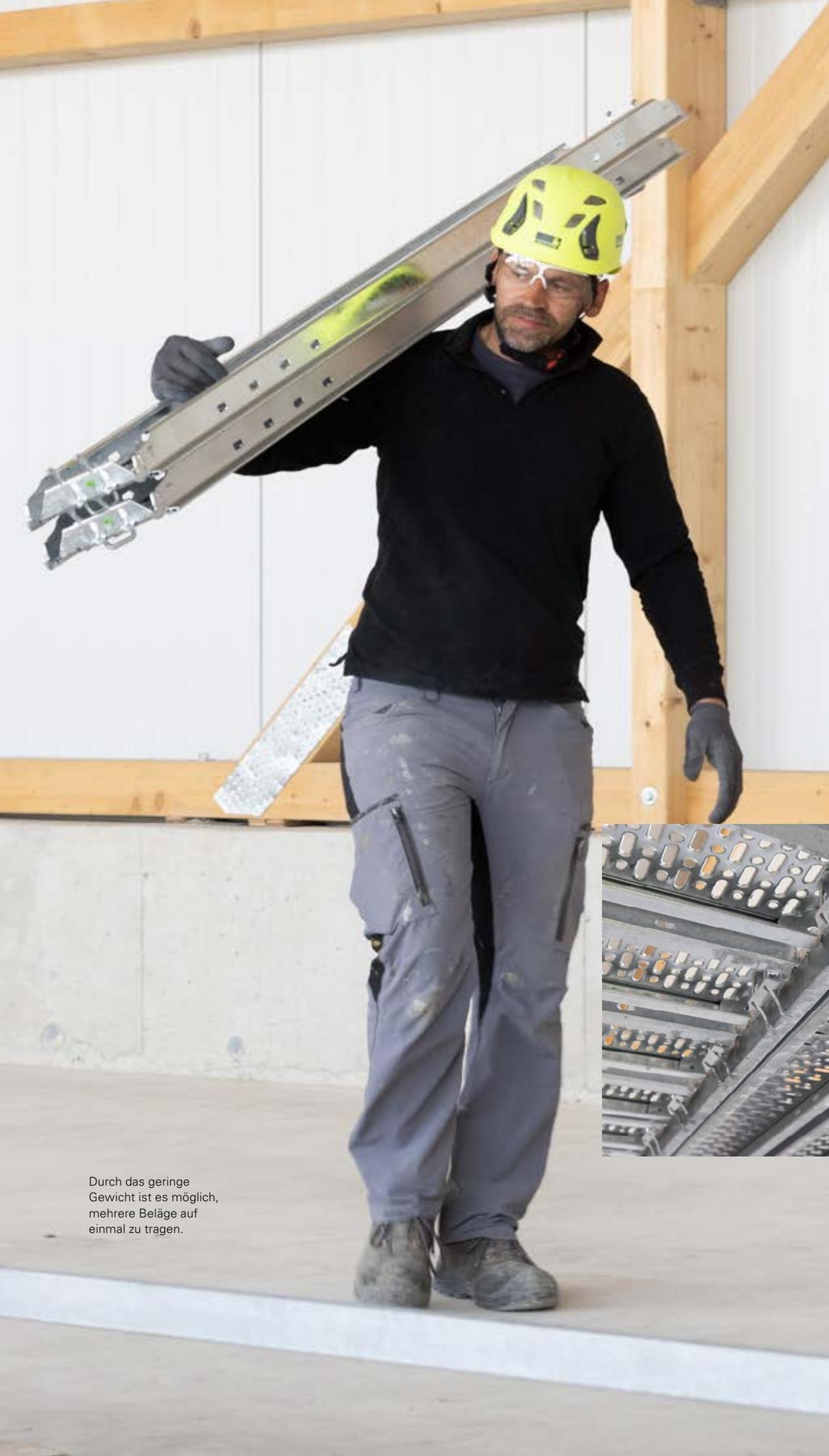
Durch das geringe Gewicht ist es möglich, mehrere Beläge auf einmal zu tragen.
