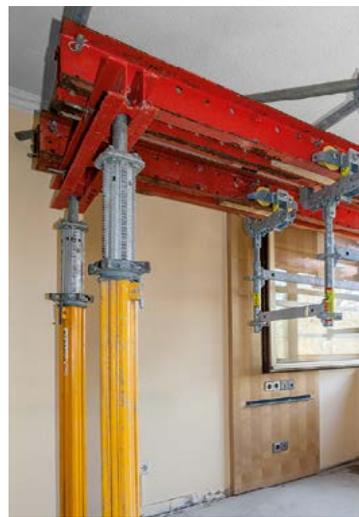
Die Laufkatze wird oft in Kombination mit den Stahlbauteilen des VARIOKIT Ingenieurbaukastens oder anderen PERI Schalungssystemen für tragende Konstruktionen eingesetzt, wie hier mit PERI RCS Schienen.
