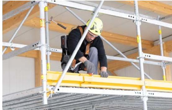
Zubehörklammern ermöglichen das stufenlose Verbinden von zwei Blechen, falls die benötigte Länge gerade nicht zur Hand ist.
