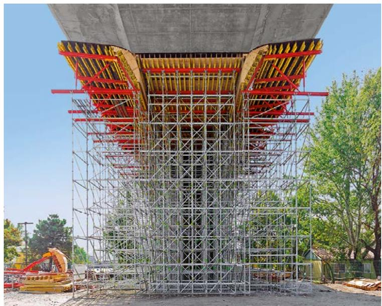
Mit dem PERI UP Stützturm erzielen Sie eine hohe Materialauslastung durch die optimale Positionierung der Stiele entsprechend der jeweiligen Lastsituation.
