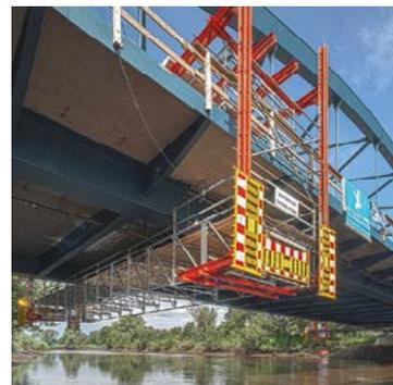
Das manuell verfahrbare Gerüst mit 20 m Spannweite auf Basis des LGS Systems dient als Arbeitsplattform für die Durchführung von Korrosionsschutzmaßnahmen.
