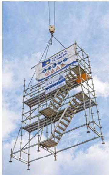
Aufgrund zugfester Verbindungen ist das PERI UP Bewehrungsgerüst selbst in großformatigen Einheiten komplett per Kran umsetzbar.
