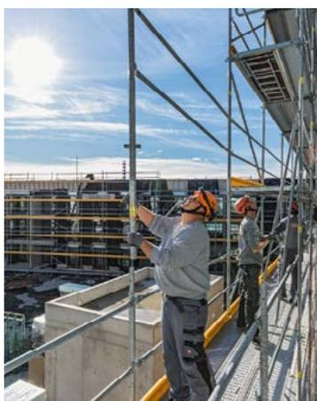
Sowohl am Stiel als auch am Rahmen können Geländerholme von der unteren Ebene aus vorlaufend montiert und demontiert werden.
