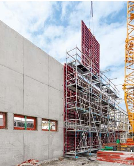
Vor Schalungen und Wänden können Sie das PERI UP Bewehrungsgerüst ganz ohne Anker und Ballastierung einsetzen.
