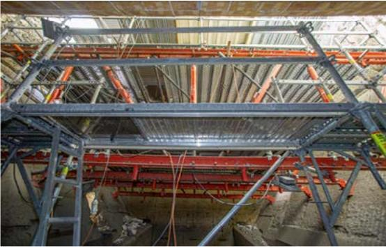
Die 3D-Planung erleichterte die Montage in den engen und staubigen Schornsteinen und half den Gerüstbauern bei der Orientierung.
