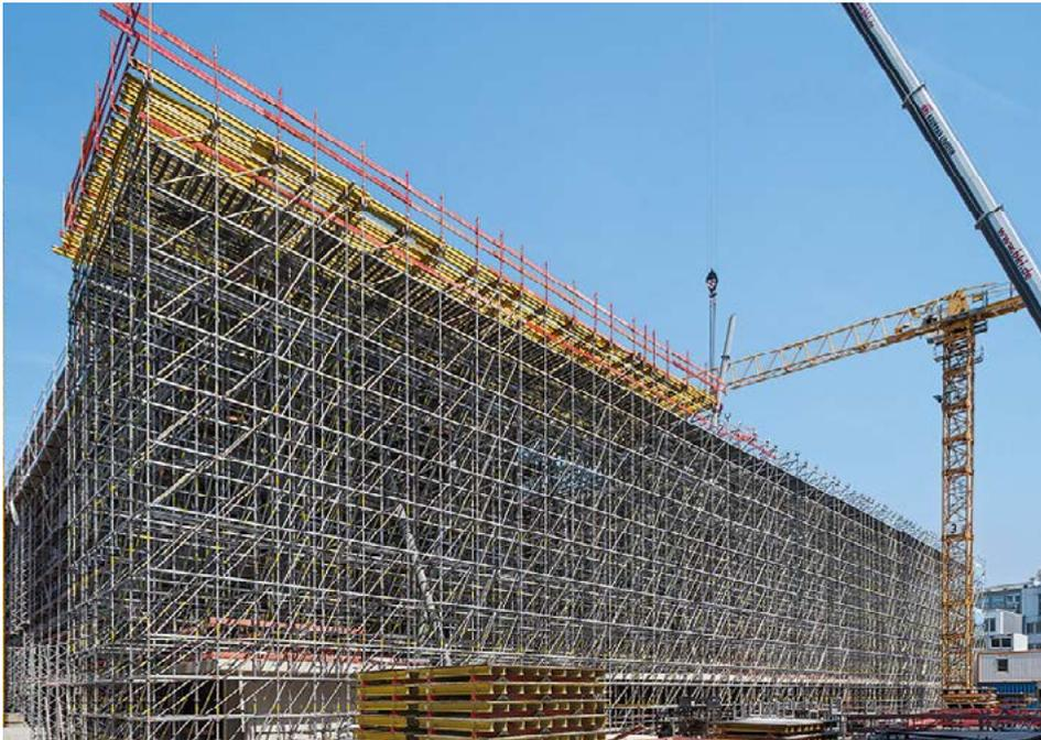
Die Stütztürme sind kompatibel mit PERI Deckenschalungssystemen. Darüber hinaus ist der PERI UP Stützturm abgestimmt auf die üblichen Stahl- und Holzbaumaße.
