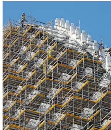
Während der Nutzung gewähren Ihnen die rutschsicheren, gelochten Beläge, umlaufende Geländer sowie die Bordbleche ein hohes Maß an Arbeitssicherheit.
