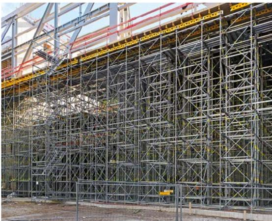
Die Kombination von 2 m langen Vertikalstielen und Kopfstielen in unterschiedlichen Längen ermöglicht Ihnen eine stufenlose Höhenanpassung.
