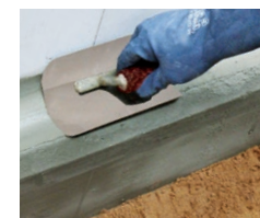
Ausbilden einer Dichtungs- / Hohlkehle am Übergang mit PCI Polyfix plus L
