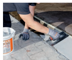
Aufbringen von PCI Aposan zum Überbrücken von Höhenunterschieden bis 50 mm
