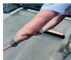
Ausführung eines Besenstrichs auf PCI Peciment 50
