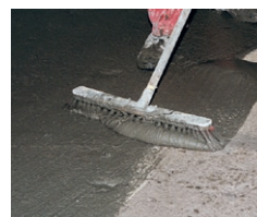
Aufbringen einer Mörtelhaftbrücke mit PCI Pecihaft
