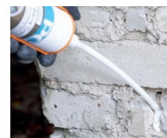
Injektion einer wasserabweisenden Horizontalsperre mit PCI Barra Creme
