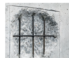
Die Bewehrungsstäbe von Rost und Altanstrichen befreien
