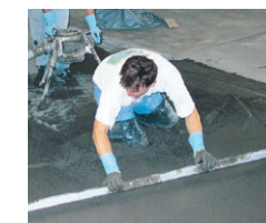
Estriche auf Dämm- und Trennlagen sind in homogenen Schichtdicken aufzubringen
