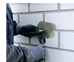
Verankern von Einbauteilen mithilfe von zementären Mörteln wie z. B. PCI Repafix
