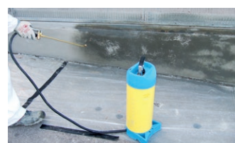
Manueller Auftrag einer PCI Silconal-Hydrophobierung als nicht filmbildende wasser- und schmutzabweisende Maßnahme
