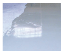
Einbau des mechanisch hoch belastbaren Zementbodenausgleichs PCI Periplan Multi in einer Gewerbehalle
