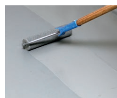
Nach zweimaligem Streichen mit PCI Supracolor ist die optische Sanierung abgeschlossen
