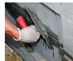
Schließen von Fugen und Angarnieren von Ecken und Kanten mit PCI Nanocret R2
