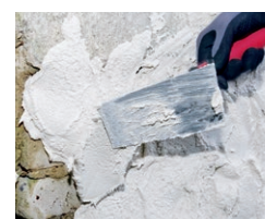
Aufbringen von PCI Saniment 2 in 1 als Sanierputz und Feinputz in einem
