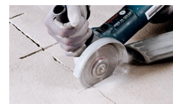
Estrich quer zur Arbeitsfuge einschneiden, aussaugen und PCI Estrichklammern einlegen
