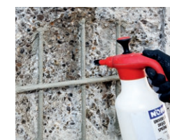
Vor der Beton-sanierung Flächen mattfeucht vornässen, ggf. mit PCI Nanocret AP grundieren
