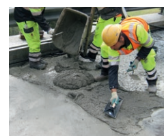
Standfester Bodenausgleich eines Betonausbruchs mit PCI Repafast Tixo
