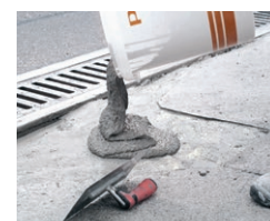
Fließfähiger Ausgleich einer Bodenfläche aus Beton mit PCI Repafast Fluid
