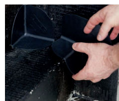
Kritische Ecken sicher abdichten mit PVC-Formteilen PCI BT 45 und PCI BT 46
