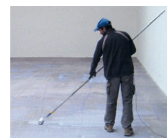
Vor dem Auftrag der fließfähigen Bodenausgleichsmasse PCI Gisogrund 404 als Haftvermittler aufbringen
