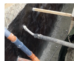
PCI Barraseal Turbo haftet selbst auf alten Bitumenabdichtungen
