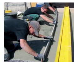
PCI Peciment 50 auf einer Brücke nach ZTV-ING
