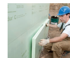
Vollflächige (oberhalb Grundwasserspiegel auch punktuell) Verklebung der Dämmplatten. Stöße der Platten anschließend verspachteln
