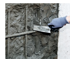
Kontaktschicht mit der ersten Lage Reparaturmörtel aufstreichen oder mit der Traufel aufkratzen
