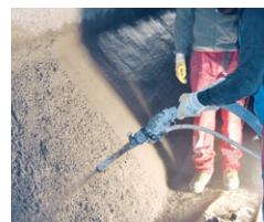
Der sulfatbeständige Reparaturmörtel PCI Nanocret R4 PCC kann sowohl händisch als auch maschinell aufgetragen werden
