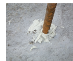
Fixieren von Verankerungen mit Methacrylat PCI Barrafix 920
