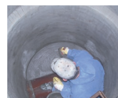
Aufbringen der mineralischen Dichtschlämme PCI Barraseal in einer Zisterne
