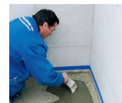
Bei Verbundestrichen ist eine Haftbrücke aus PCI Repahaft aufzubringen
