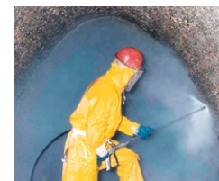
Vorbereiten einer geschädigten Betonoberfläche in einem Kanal
