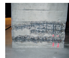
Freilegen eines mit Chlorid geschädigten Betons in einer Tiefgarage
