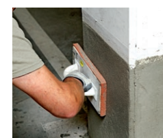
Schließen von Lunkern mit dem Feinspachtel PCI Nanocret FC
