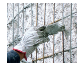
Vorbehandlung der Bewehrungsstäbe mit dem aktiv ausgestatteten Bewehrungsschutz PCI Nanocret AP / PCI Legaran RP
