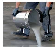
Aufbringen der Verlaufsbeschichtung
