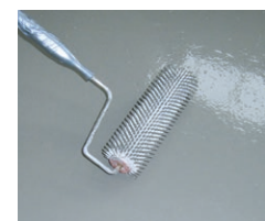
Das Material gleichmäßig verteilen und mit einer Stachelwalze entlüften
