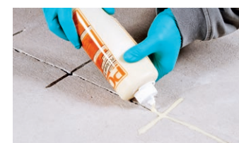
PCI Apogel SH in eine Kartusche umfüllen, mischen und gleichmäßig in die vorbereitete Fuge füllen
