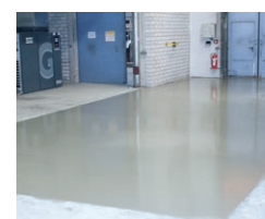
Ausgleich eines Betonbodens mit leicht verlaufendem Fließestrich PCI Zemtec 180
