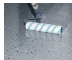
Eingestreute Farbchips mit PCI Pursol transparent versiegeln. Bei Beschichtungen ohne Farbchips kann die 2. Lage mit PCI Pursol 1K farbige erfolgen
