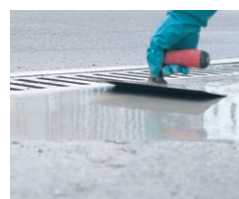
Anarbeiten an eine Rinne mit dem Epoxi-Vergussmörtel PCI Repaflow EP Plus
