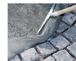
Einbringen des zementären Pflasterfugenmörtels PCI Pavifix CEM auf eine vorgeässte Pflastersteinfläche
