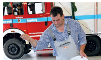
Einstreuen von Farbchips in die noch frische Beschichtung
