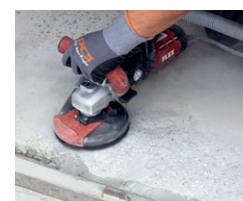
Alte Rückstände und Verunreinigungen durch Abschleifen entfernen
