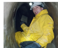
Aufbringen der sulfatbeständigen Dichtschlämme PCI Barraseal im Bereich von Abwässern
