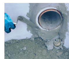
Setzen von Muffen mithilfe von zementären Mörteln wie z. B. PCI Repafix
