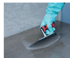
Eine porenfreie Kratzspachtelung ermöglicht eine sichere Haftung und blasenfreie Aushärtung der nachfolgenden Beschichtung
