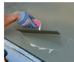
Und mit einer Rake in der gewünschten Schichtdicke verteilt
