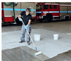
Grundieren der vorbereiteten Fläche mit Epoxidharz wie z. B. PCI Epoxigrund 390
