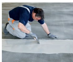
Händisches Anarbeiten an eine Dehnfuge
