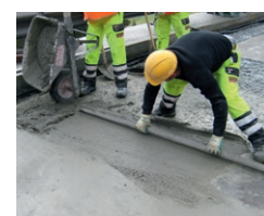
Standfester Ausgleich einer Bodenfläche aus Beton mit PCI Repafast Tixo
