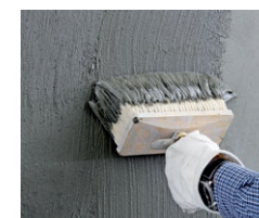
Aufbringen der mineralischen, sulfatbeständigen Abdichtung PCI Barraseal
