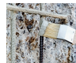
Den aktiv ausgestatteten Bewehrungsschutz PCI Nanocret AP in mindestens zwei Lagen volldeckend auftragen
