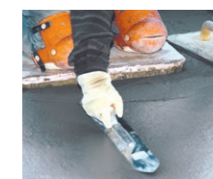
Estriche oberflächlich mit einer Traufel glätten
