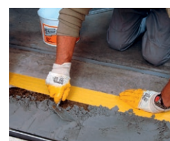
Ausgleich einer Schwelle oder Treppenstufe mit standfestem Epoxi-Mörtel PCI Aposan
