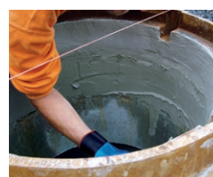
Auskleiden eines Schachtrings und Setzen mit PCI Polyfix plus L
