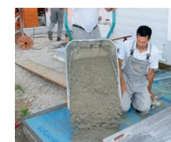
Einbau des Monokornmörtels PCI Pavifix DM auf eine unterstützende Drainmatte
