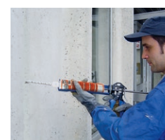
Verfüllen von Verankerungen mit Methacrylat PCI Barrafix 920
