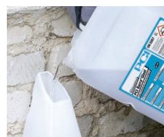
Mauerwerk mit der flüssigen Horizontalabdichtung PCI Barra Gisol gegen aufsteigende Feuchtigkeit schützen
