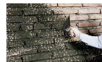
Aufbringen eines Spritzbewerfs, vergütet mit PCI Emulsion
