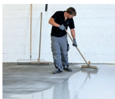
Verteilen mit Rake und Stachelwalze
