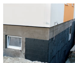
Übergang einer Schwarzabdichtung mit PCI Barraseal Turbo über die Geländeoberkante
