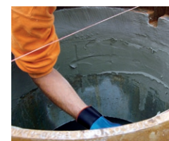
Anputzen und Setzen eines Schachtrings mit PCI Polyfix plus L
