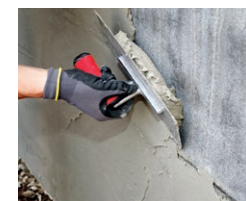
Aufbringen des faserverstärkten Feinspachtels PCI Nanocret FC
