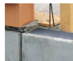
PCI Barraseal Turbo als Horizontalsperre unter Wänden
