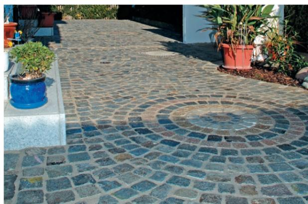
Ein ungebundener, ausreichend verdichteter Unterbau, in Kombination mit einer gebundenen drainfähigen Verfugung bietet viele Vorteile.
