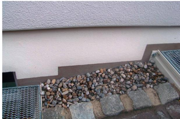
Auf Pflaster- und Natursteinflächen angrenzende Bereiche sollte ein besonderes Augenmerk gerichtet werden. Hier ist vor allem der Übergang der Sockelzone an der Außenwand zur Pflaster- und Natursteinfläche starken Belastungen durch Witterungseinflüssen ausgesetzt.
