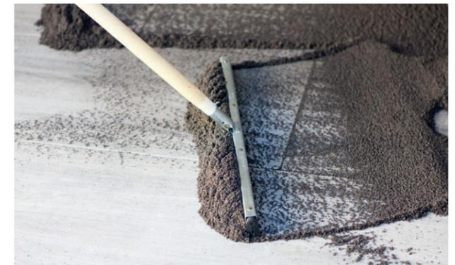
Den drainfähigen Fugenmörtel PCI Pavifix 1K Extra in die Fugen einbringen. Anschließend die Flächen sauber abspülen und abkehren.
