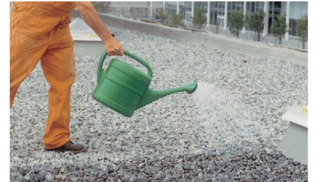
Verfestigung einer Kiesschüttung mit PCI Stabiflex.
