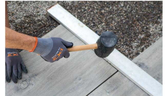
Auf die Platten rückseitig PCI Carrament als Haftbrücke/Kontaktschicht auftragen und fest in den Drainmörtel einklopfen.
