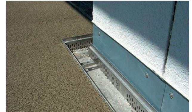
Drainfähiger gebundener Unterbau aus PCI Pavifix DM.
