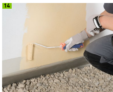
14 Sockel mit wasserabweisender Farbe anstreichen
