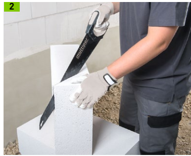
2 Multipor Sockeldämmplatte schräg zuschneiden
