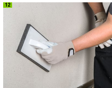
12 Oberputz filzen oder strukturieren
