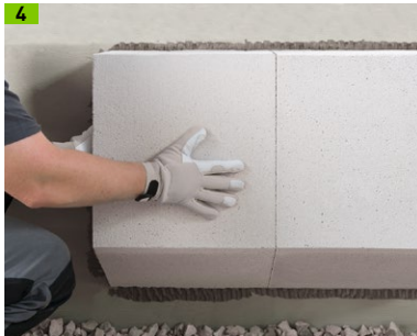
4 Multipor Sockeldämmplatte andrücken und einschwimmen
