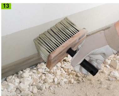
13 Erdberührten Bereich des Oberputzes zum Feuchteschutz erneut mit Multipor Dichtschlämme beschichten
