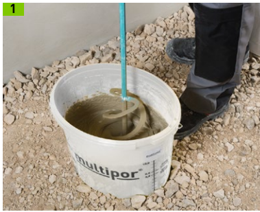
1 Multipor Dichtschlämme anmischen
