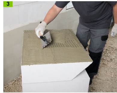
3 Multipor Dichtschlämme mit 12 mm-Zahntraufel vollflächig auftragen
