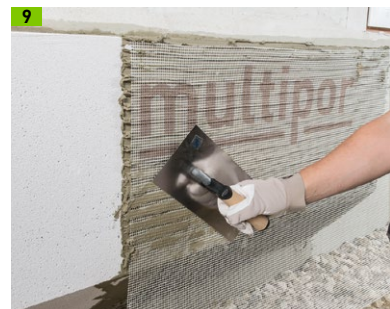
9 Multipor Armierungsgewebe auflegen und einputzen
