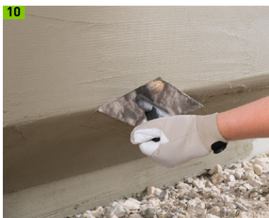
10 Armierungsschicht abziehen und 24 Stunden trocknen lassen
