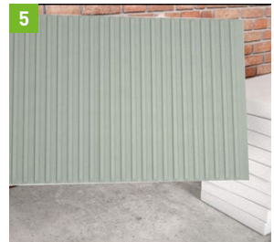
5 FIX X730 vollflächig auf Entsalzungsplatte auftragen.
