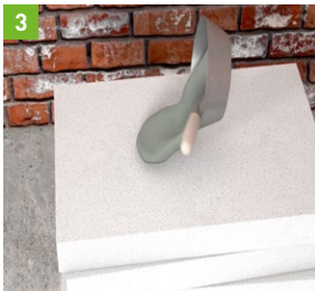
3 FIX X730 auf die Entsalzungsplatte auftragen.
