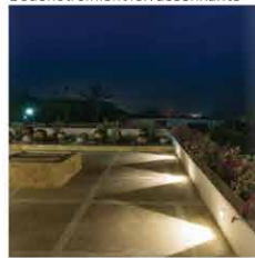
TERRASSE Bodenstreiflicht Terrassenkante
