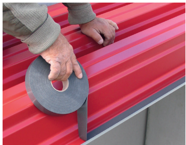
Einbaubeispiel: ISO-ZELL FIXBAND
