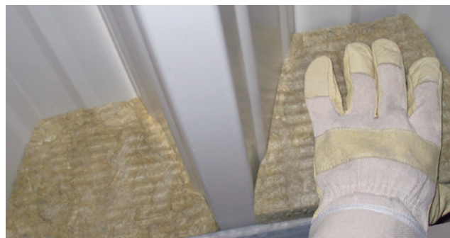
Einbaubeispiel: ISO-PROFIL FÜLLERSTÜCKE
