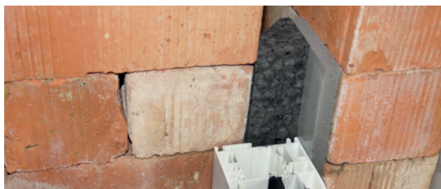
Einbaubeispiel: ISO-BLOCO FILLER
