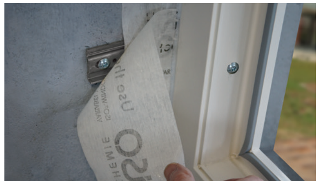
Einbaubeispiel: ISO-CONNECT VARIO SD „PADS“
