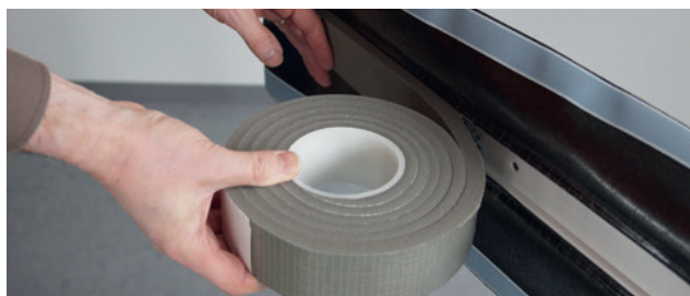
Einbaubeispiel: ISO-BLOCO HF
