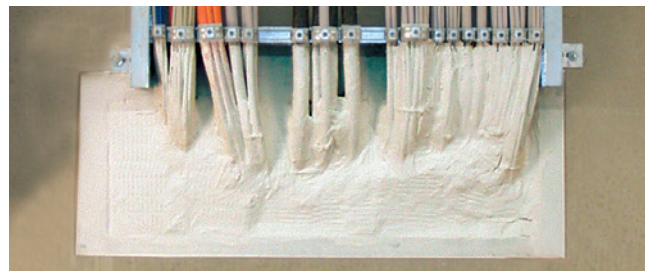
Einbaubeispiel: ISO-FLAME PLATTE S 90
