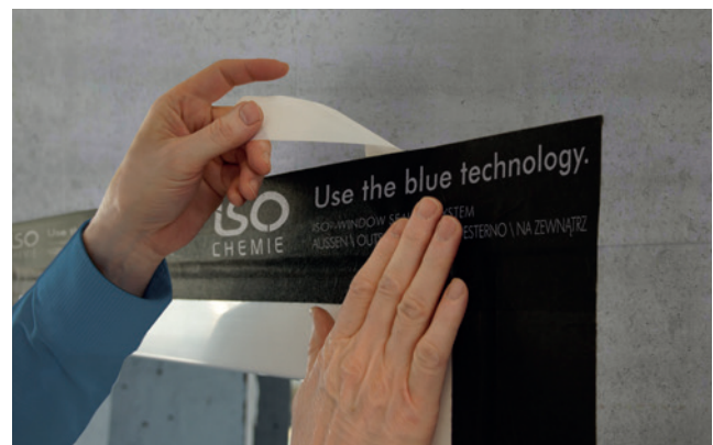
Einbaubeispiel: ISO-CONNECT OUTSIDE CL
