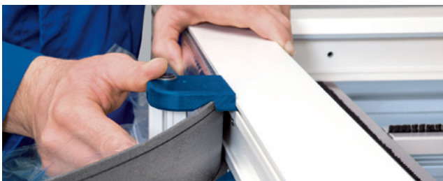
Einbaubeispiel (CB): Kunststofffenstermontage
