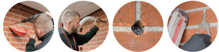
Und das nahezu staubfrei, da das EPS-Granulat mit geringem Druck eingeblasen wird. Die sich ergebenden minimalen Öffnungen in der Fassade können einfach und in der Regel ohne größere optische Beeinträchtigungen wieder geschlossen werden.
