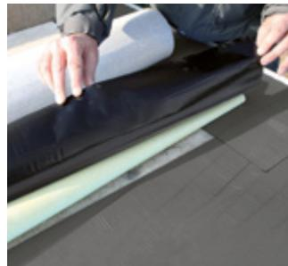
Zum Verkleben mit dem Untergrund wird die DiProtec® KSK-Bahn umgeschlagen, das Silikonpapier abgezogen und die Bahnen mit mind. 10 cm Überlappung verklebt.
