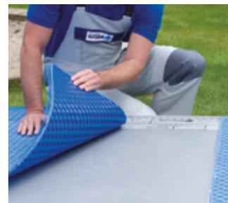
Direkt nach Verlegung der Schnelldichtbahn kann ein drainierender Belagsaufbau mit AquaDrain®, Watec® oder TerraMaxx® Systemen ausgeführt werden.
