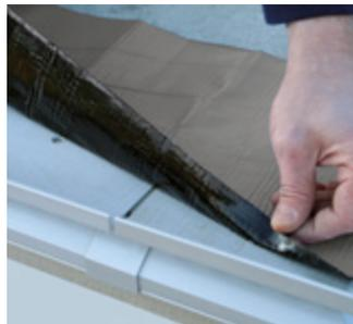
Das DiProtec® KSK-AB Abdichtungsband – ausgestattet mit einem zweigeteilten Silikonpapier – wird auf den Profilschenkel aufgeklebt.
