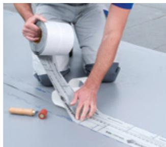
Die Verbindung der Abdichtungsbahnen untereinander und der Anschluss an Profile erfolgt einfach, sicher und schnell dank der GUTJAHR Dichtbandtechnologie mit den speziellen selbstklebenden DiProtec® AB-K Dichtbändern.
