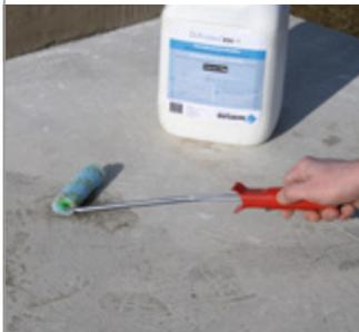
Abzudichtende Flächen, Boden und Sockelbereich werden mit DiProtec® PR-ZE Primer grundiert.
