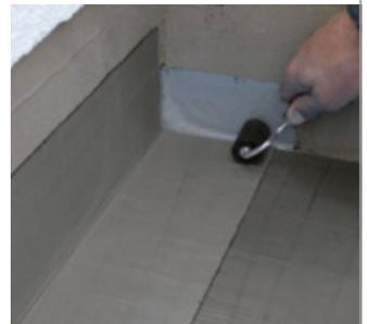
Der Boden-Wandanschluss erfolgt mit dem DiProtec® KSK-AB Abdichtungsband, das ebenfalls mit 10 cm Überlappung mit der DiProtec® KSK-Bahn verklebt wird.
