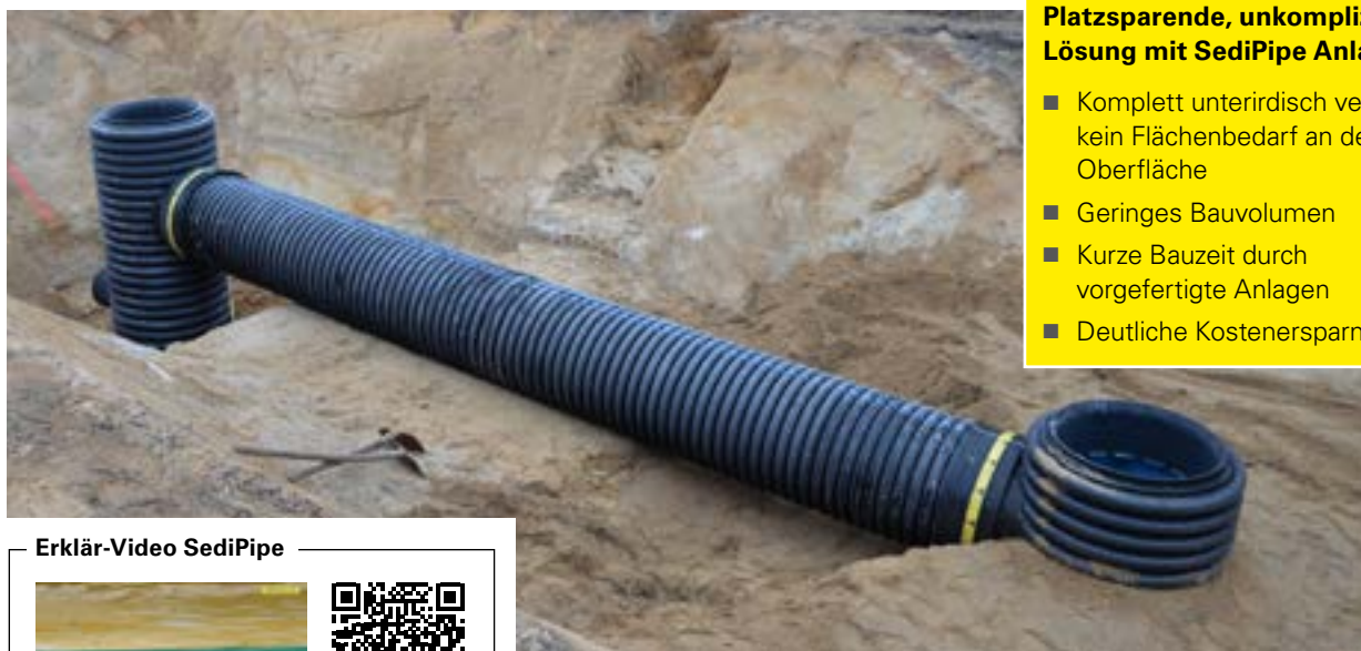
SediPipe L ersetzt ein Regenklärbecken in Betonbauweise
