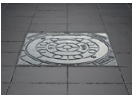
quadratische Schachtabdeckung (Guss), Klasse B 125, 35 x 35 cm
