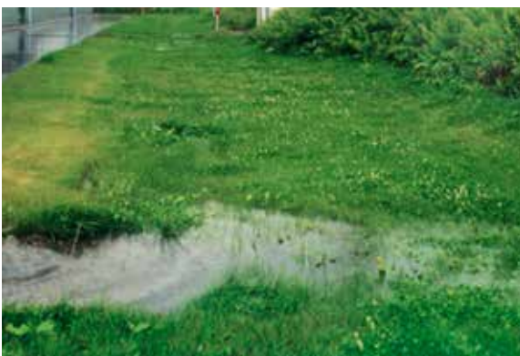
Ortsnahe Versickerung in Form der Mulden-Rigole
