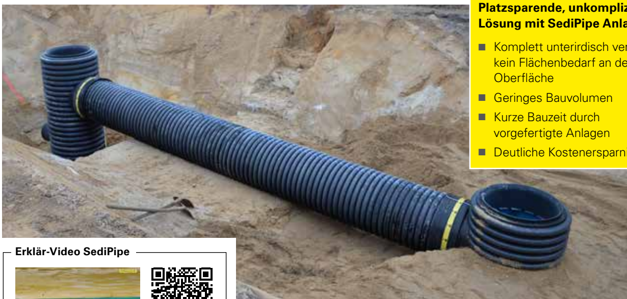
SediPipe L ersetzt ein Regenklärbecken in Betonbauweise
