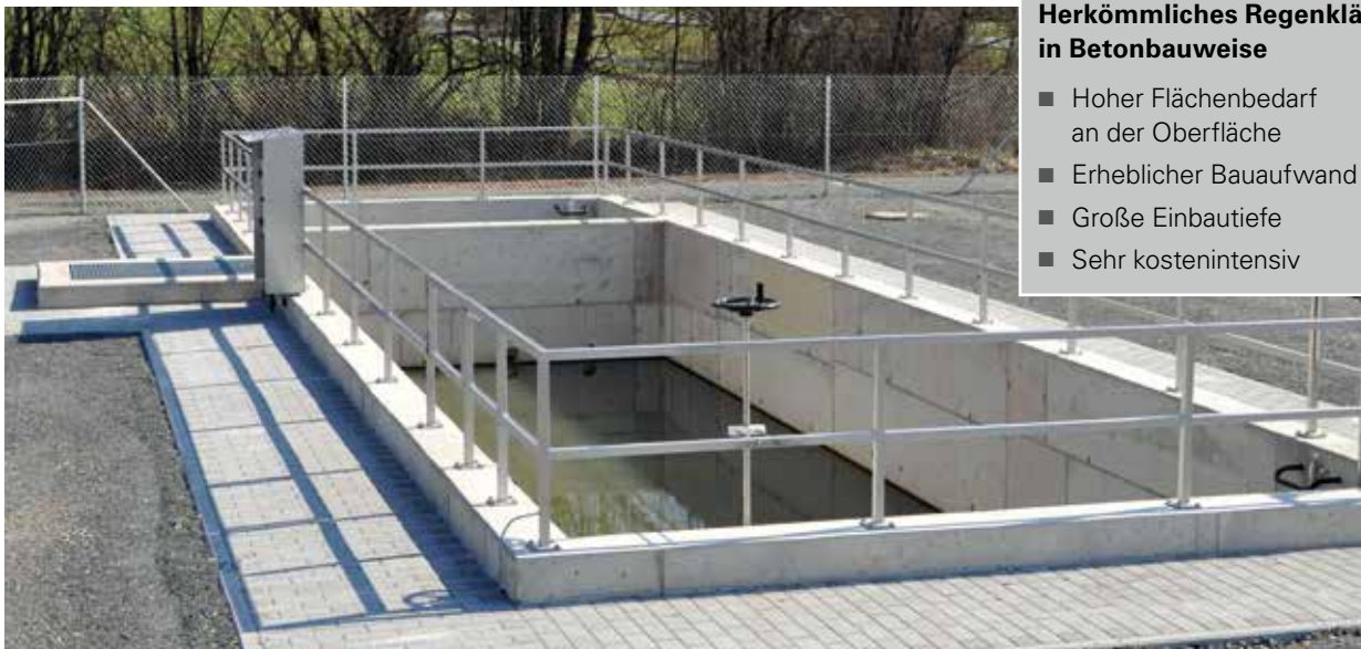
Regenklärbecken in Betonbauweise
