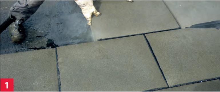
In der Variante „FOAMGLAS® Platten mit Heißbitumen“ werden diese vollflächig mit gefüllten und versetzten Fugen im Gießverfahren mit Heißbitumen auf dem tragenden Untergrund, z. B. Beton, verlegt.
