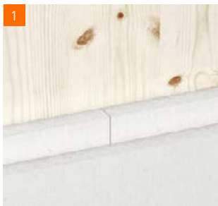
1 Direkt Beplankung auf Massivholz/ Brettsperrholz (alternativ Holzwerkstoffplatten)
