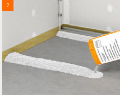
Anlegen der Dämme
