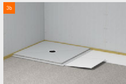
Variante B: Um auf die Höhe des Stufenfalzes vom Duschelement zu kommen, wird über die Fläche 10 mm dicker Dämmstoff (EPS DEO 150) verlegt
