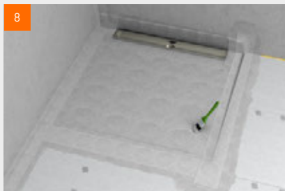
8 Anschlüsse an angrenzende Bauteile mit geeigneter Verbundabdichtung und Systemkomponenten abdichten, z.B. mit in Dichtschlämme eingelegten Dichtbändern. Anschließend den Gefällebereich vollflächig nach Herstellervorgabe abdichten.
