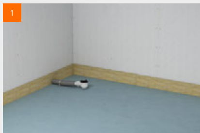
Nachdem die Lage des Duschelements markiert ist, wird das Ablaufgehäuse gesetzt
