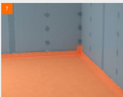
7 Bei der Verwendung von Gipsfaser Estrich-Elementen in Klasse W1-I muss zusätzlich eine vollflächige Abdichtung erfolgen. fermacell™ Flüssigfolie mit der Rolle mind. 2 x vollflächig auftragen (Trockenschichtdicke mindestens 0,5 mm). Gemäß DIN 18534-3 wird für den 2. Auftrag ein Farbunterschied zur besseren Nachvollziehbarkeit gefordert. 1. Auftrag: fermacell™ Flüssigfolie in Originalfarbe satt auftragen und trocknen lassen.
