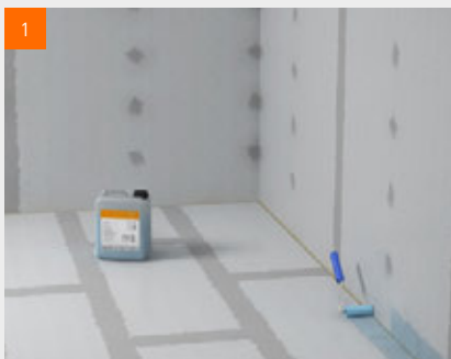
1 fermacell™ Tiefengrund im angrenzenden Wandbereich ...
