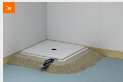
Variante A: Um das Duschelement wird in Höhe des überstehenden Falzes ein ca. 200 mm breiter Dämm geschüttet – als Auflage für das Abziehen der restlichen Fläche
