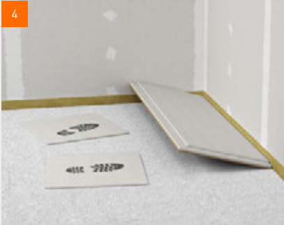
Verlegen der fermacell® Estrich-Elemente auf fermacell™ Ausgleichsschüttung
