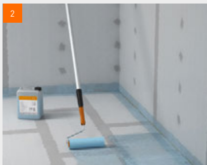
2 ... und Bodenbereich per Rolle auftragen - Trocknungszeit mindestens 2 Stunden
