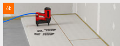
Befestigen durch Verschrauben oder Spezial-Spreizklammern innerhalb von 10 Min.
