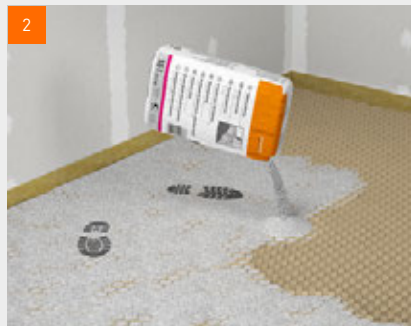
fermacell™ Wabenschüttung einbringen
