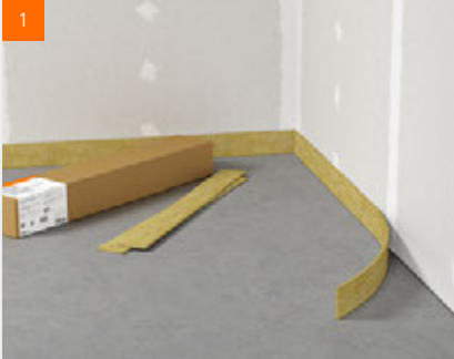
Anbringen der Randdämmstreifen
