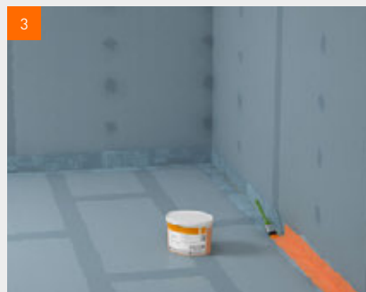
3 fermacell™ Flüssigfolie in der Ecke auftragen
