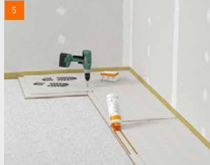
Verlegen der fermacell® Estrich-Elemente auf fermacell™ Ausgleichsschüttung
