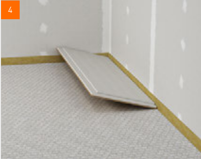
fermacell® Estrich-Elemente verlegen
