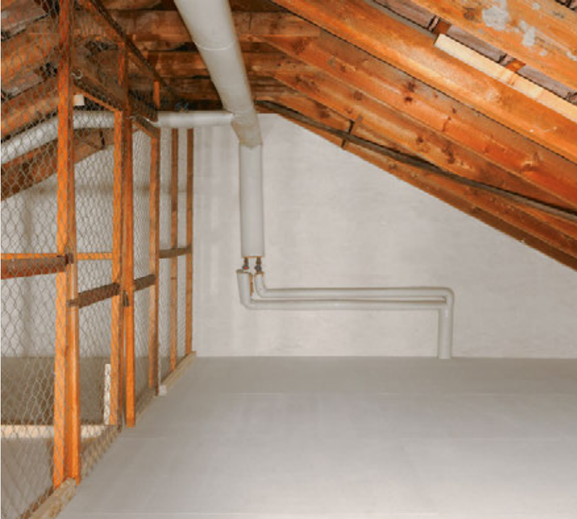
Nut- und Federverbindung: Schnelle Verlegung ohne Wärmebrücken
