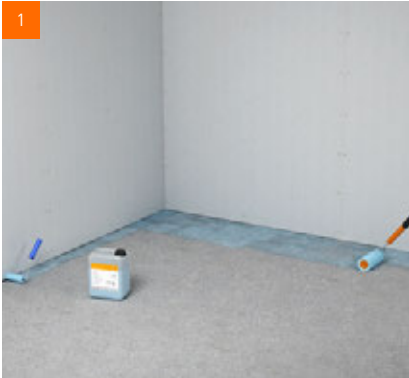
1 Grundierung des Untergrundes mit fermacell™ Tiefengrund
