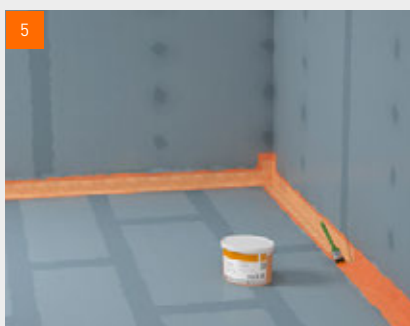
5 Dichtband direkt nach dem Eindrücken mit fermacell™ Flüssigfolie überstreichen - Trocknungszeit mindestens 1 Stunde
