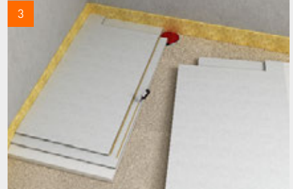
3 Erstes Gefälle-Element ausrichten, fermacell™ Estrich-Kleber auf Stufenfalz auftragen, beide Gefälle-Elemente zusammenfügen und miteinander verschrauben.
