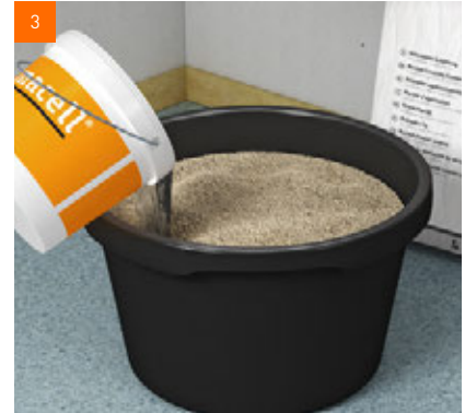
3 Der gesamte Sackinhalt ist in einem geeigneten Mischbehälter mit ca. 8-10 Liter Wasser ...
