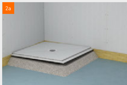
Variante A: In der Höhe der Oberkante des Ablaufgehäuses wird im Bereich des Duschelements die gebundene Schüttung abgezogen und das Duschelement gesetzt
