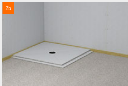
Variante B: Man zieht in Höhe der Oberkante des Ablaufgehäuses die gesamte Fläche mit der gebundenen Schüttung ab und setzt das Duschelement
