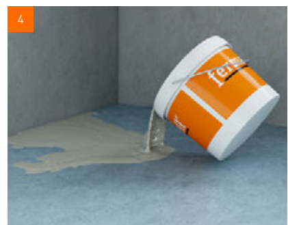
Boden-Nivelliermasse ausbringen und planeben nivellieren
