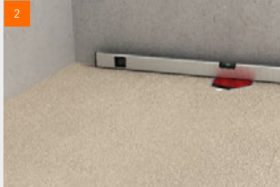
2 fermacell™ Gebundene Schüttung nach Verpackungsangaben mischen und auf Höhe der Oberkante des Ablauftopfes (ca. 95 mm) ausnivellieren sowie auf Ebenheit überprüfen.
