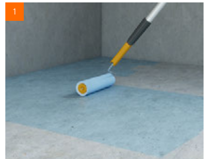
Vorbereitung: Boden grundieren
