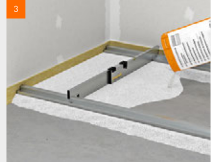
fermacell™ Ausgleichsschüttung einbringen
