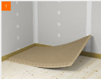
fermacell™ Estrich-Wabe verlegen
