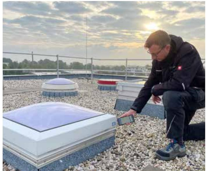
Zum Auslesen reicht es, ein NFC-fähiges Smartphone in die Nähe des Aufklebers mit dem Chip zu halten. Als Alternative zum Chip ist ein QR-Code aufgedruckt.
