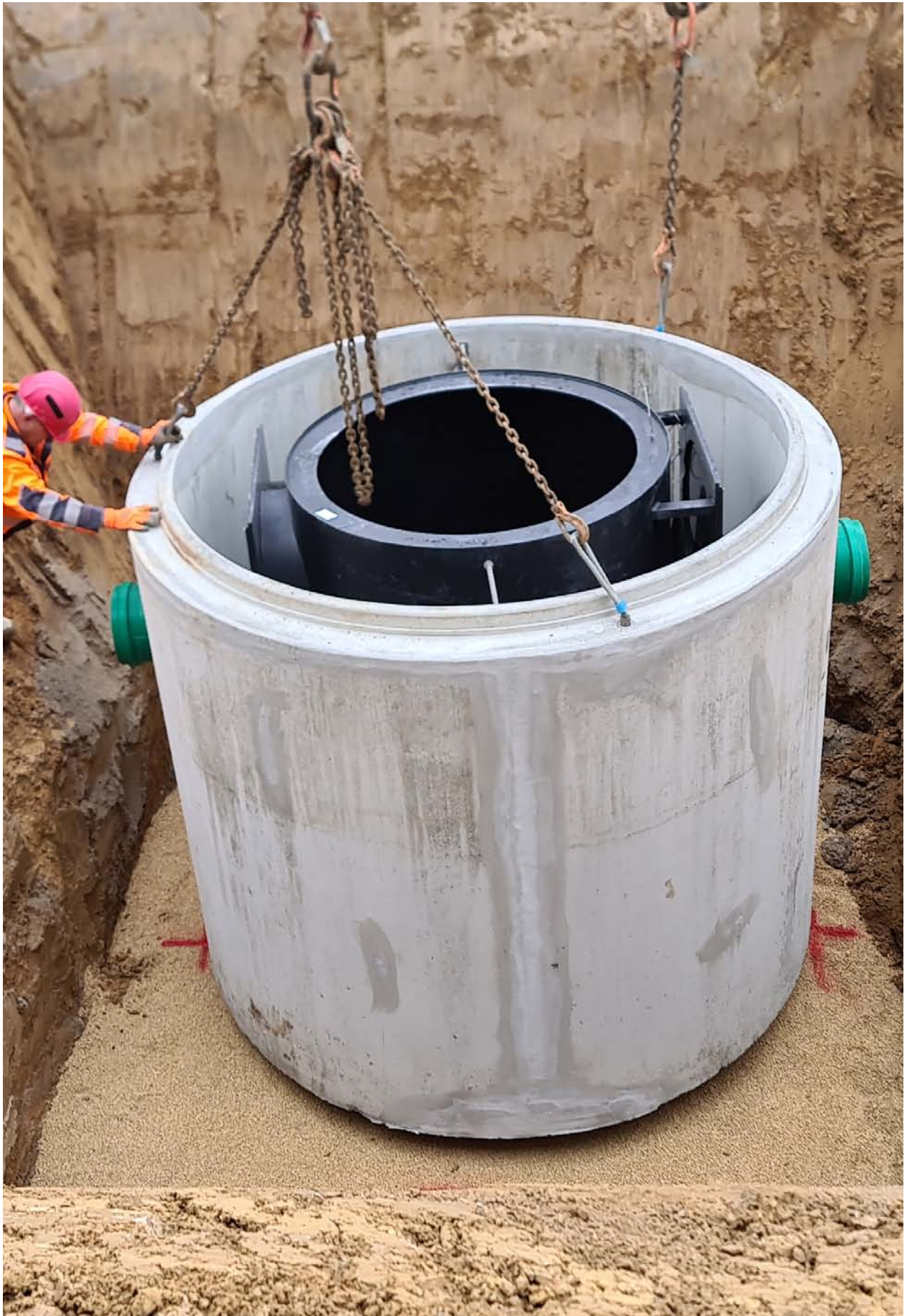
Einbau von BIRCOhydroshark
