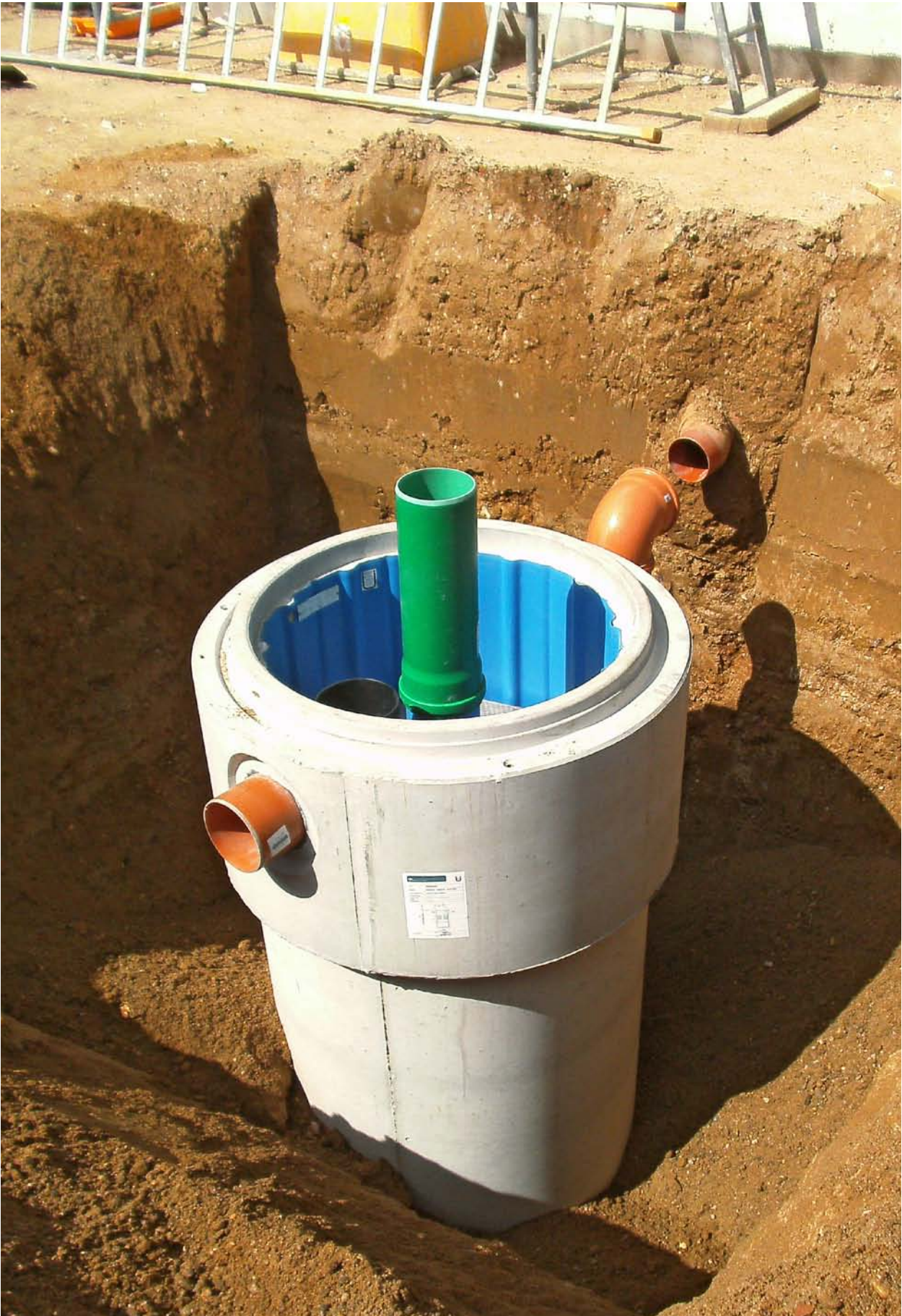
Einbau von BIRCOhydropoint® an einem Mehrgenerationenhaus in Bietigheim
