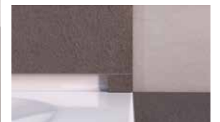
Ein kleines Fliesenstück wird hinter der Duschatrennung aufgesetzt, um den Hohlraum zu schließen
