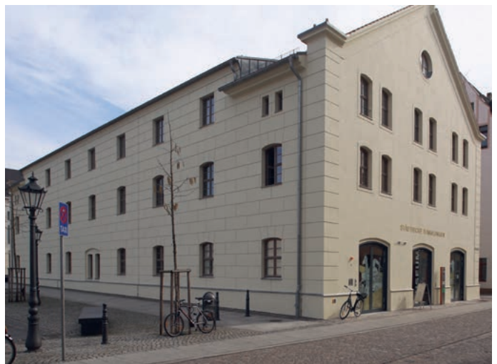
Artilleriewagenhaus in Wittenberg nach der Fassadensanierung
