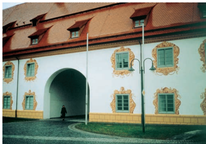
Nach der Sanierung mit Baunit Sanierputzen erstrahlt das Rathaus in Rot a. d. Rot in neuem Glanz
