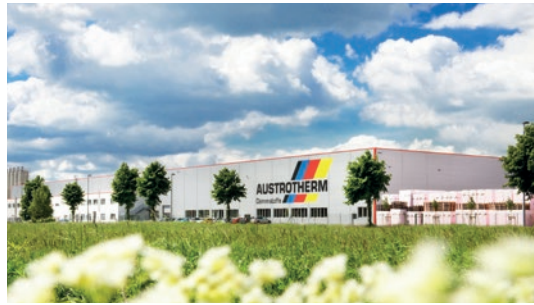
Austrotherm Deutschland Zentrale und Werk Wittenberge
