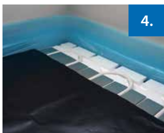
Abbildung 4: Verlegung PE-Abdeckfolie
