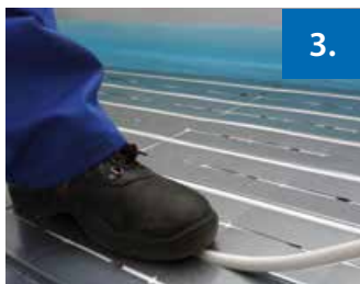
Abbildung 3: Heizrohrverlegung
