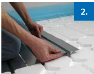
Abbildung 2: Verlegung der Wärmeleitbleche
