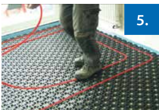
Abbildung 5: Rohrbefestigung
