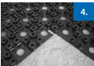
Abbildung 4: Verlegung Systemplatte
