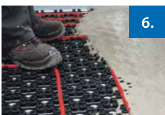
Abbildung 6: Ausgleichsmasse einbringen
